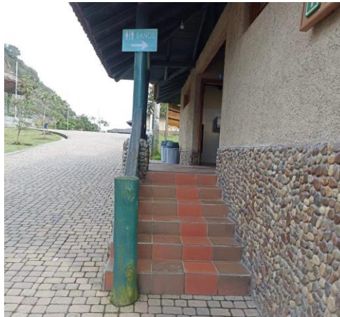
Escalera de los servicios higiénicos
