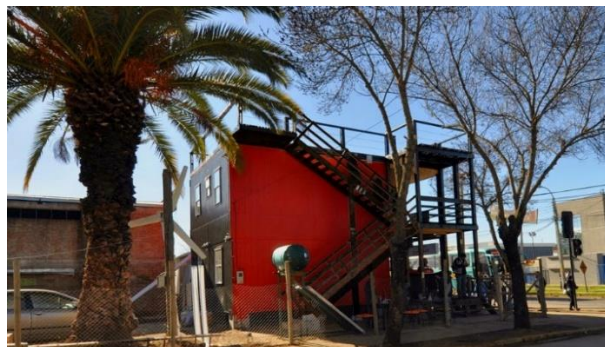
Figura 11: Mathias Klotz, casa modular luego del terremoto 2010. Inauguración (Tomado de: https://aibarchitecture.blogspot.com/2010/12/obra-ganadora-biblioteca-publica-de.html )
