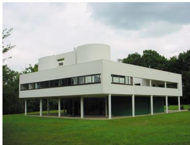
Figura 19 : La Villa Savoye en Poissy. Vivienda que aplica los 5 puntos para una nueva arquitectura. (Valueyou, cc v. 3.0)
