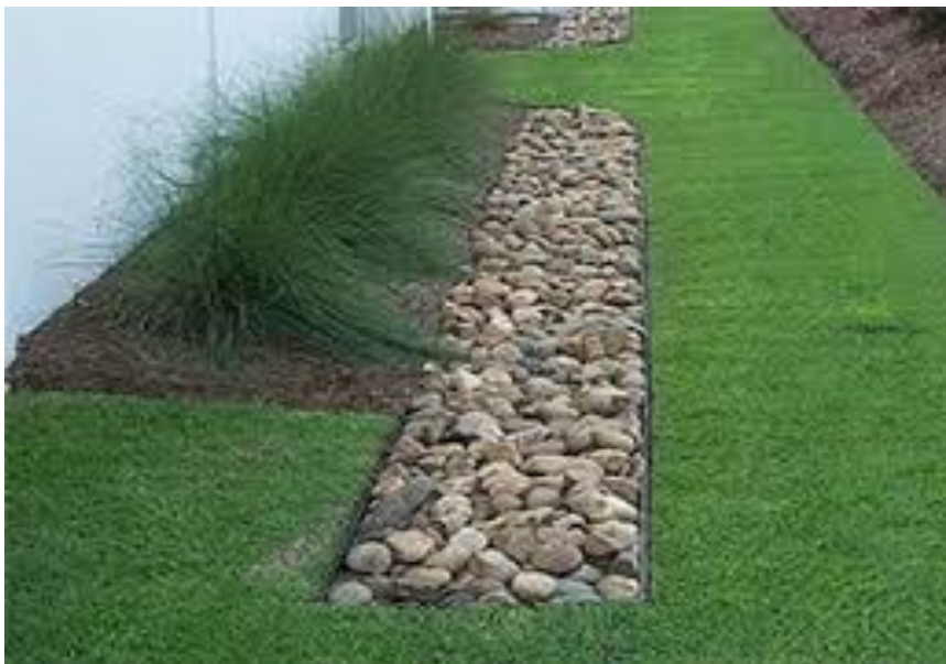
Figura 2. Zanjas de infiltración.
