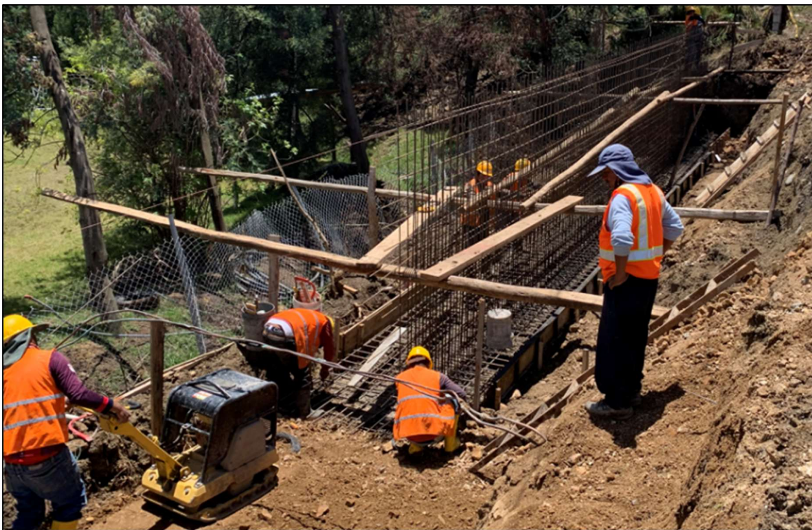
Elaboración de muro en la calle Cultura Challuabamba, sector Challuabamba.
