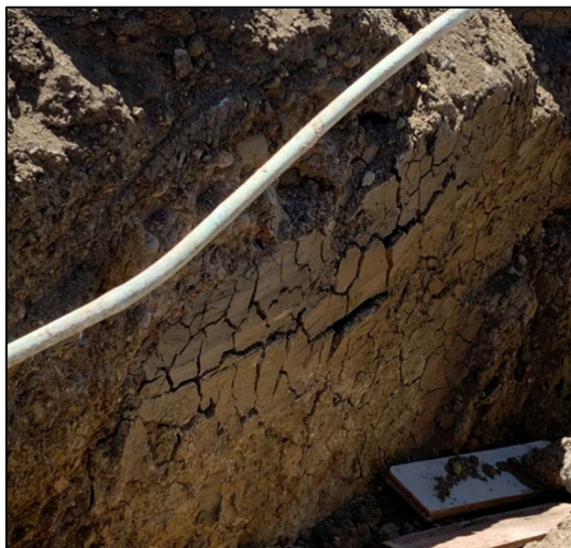
Figura 34. Taludes de suelo agrietado en el sector Challuabamba.
