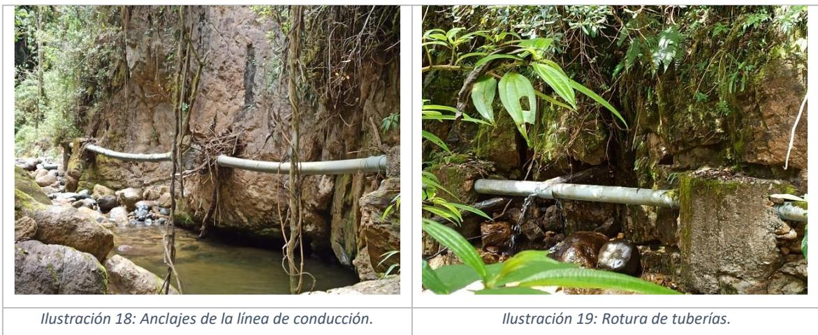
*Ilustración 18: Anclajes de la línea de conducción.*
