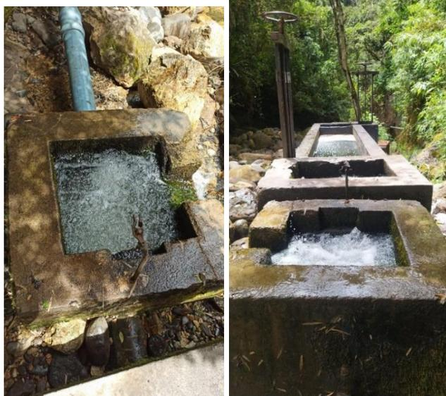
*Ilustración 3: Tanque rompe presiones y desripiador existente en la línea de conducción del Sistema de agua potable de Sinincay. Fuente: Los autores*
