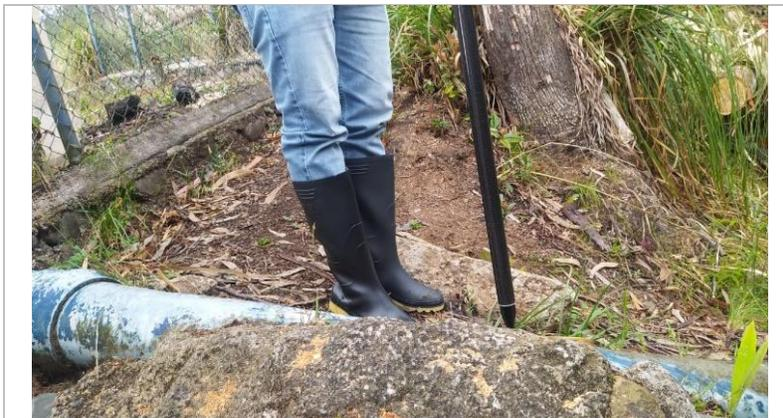
*Ilustración 22: Llegada de la línea de conducción a la planta. Con accesorio de codo alargado.*
