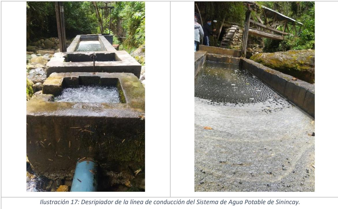
*Ilustración 17: Desripiador de la línea de conducción del Sistema de Agua Potable de Sinincay.*
