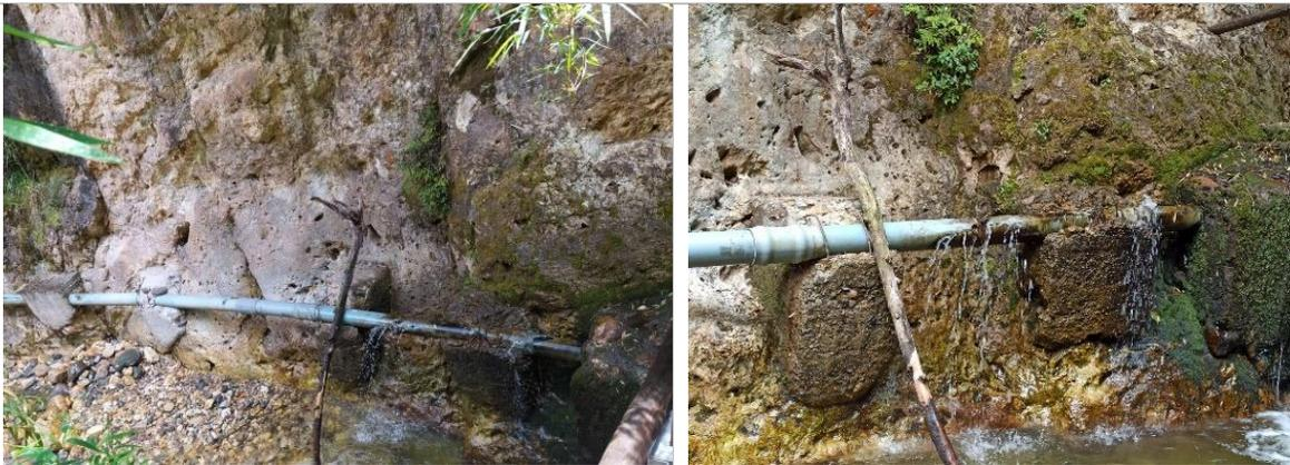
*Ilustración 16: Rotura de tuberías en la línea de conducción de Sinincay.*
