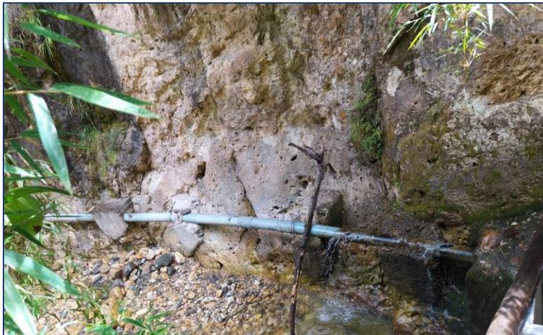
*Ilustración 2: Línea de conducción a presión. Sistema de abastecimiento de agua potable de Sinincay.*
