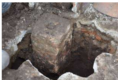
Fig. 4. Basa de piedra perdida por sucesivos cambios en nivel de piso.
