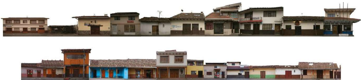
Figura 2. Dos de los tramos que conforman la calle Las Herrerías, antes de ser intervenidos durante la campaña de mantenimiento 2017-2018. Fuente: Proyecto CPM, 2017
