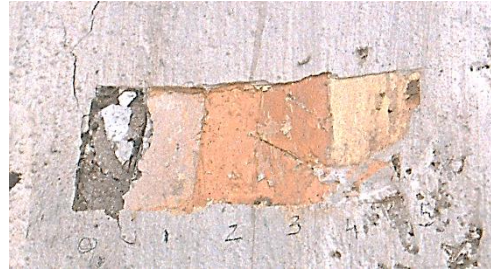
Figura 5: Cala de prospección en pared en la edificación ubicada en la calle Larga 5-14 entre Mariano Cueva y Hermano Miguel.
