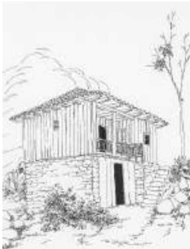
Figura 4. Cañar, El Tambo. Edificación con sistema de construcción mixta.
