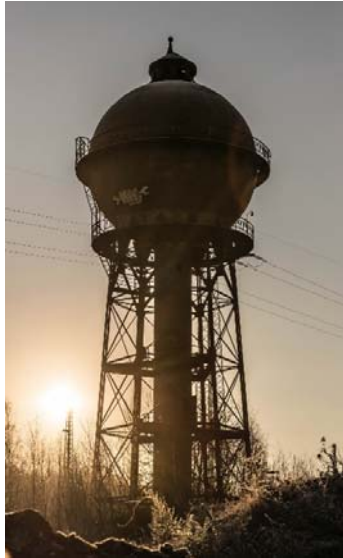
Ilustración 2.2.1: Torre con tanque de reserva.
