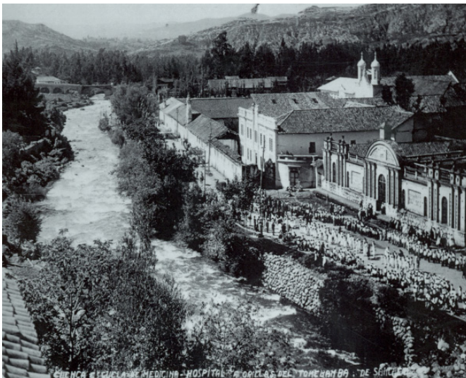
Fig. 1: Cuenca Escuela de Medicina – Hospital a Orillas del Tomebamba; Fuente: Fototeca del Banco Central de Ecuador. Sanchez, José Salvador; s/f
