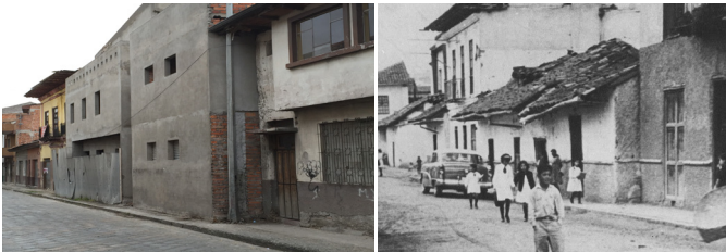
Fig. 1: Casa "El Vado", calle Presidente Córdova, destrucciones que generan efecto dominó de alteraciones en el Centro Histórico de Cuenca. Fuente: Fausto Cardoso, 2016
