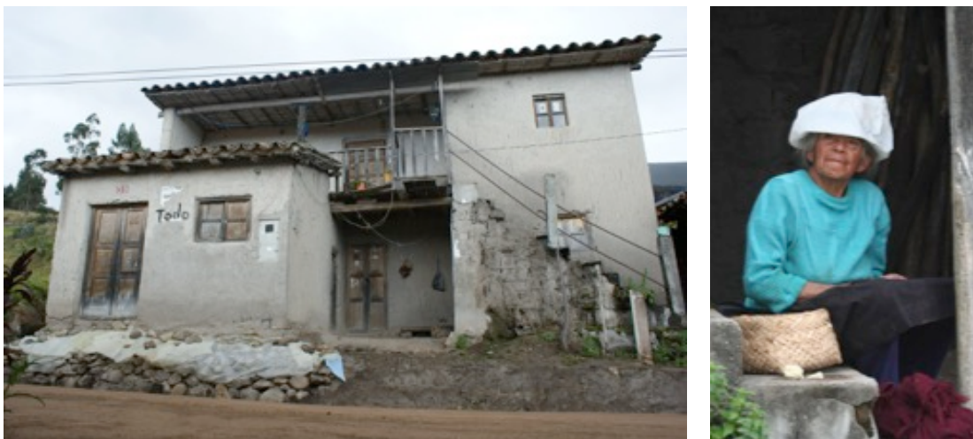
Figura 1. La casa de Gerardina antes de la intervención. Gerardina.
