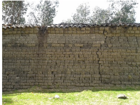
Figura 2 – Muro 1 Centro: Cerramiento del Hospital Mariano Estrella, mayo 2015
