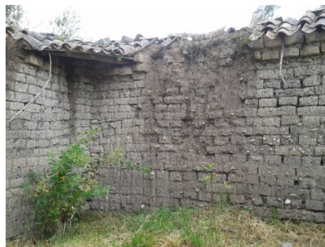
Figura 3 – Muro 2 esquina con muro 1: Cerramiento del Hospital Mariano Estrella, mayo 2015
