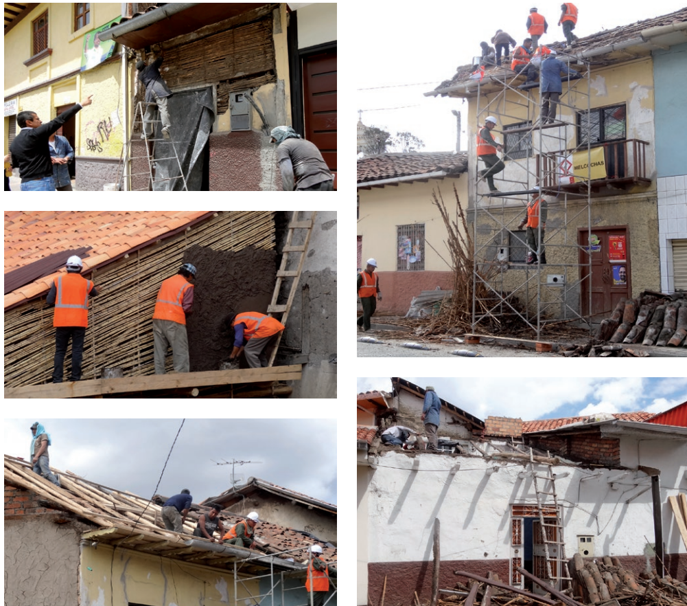
Gráfico 8. Fotografías de la intervención en cubiertas y en fachadas Fuente: Proyecto vliirCPM
