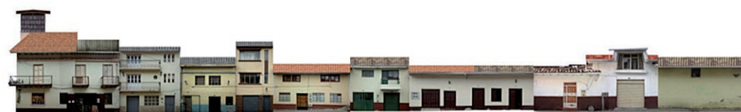
Tramo Calle del Farol - 2012
