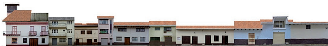
Tramo Calle del Farol - 2014
