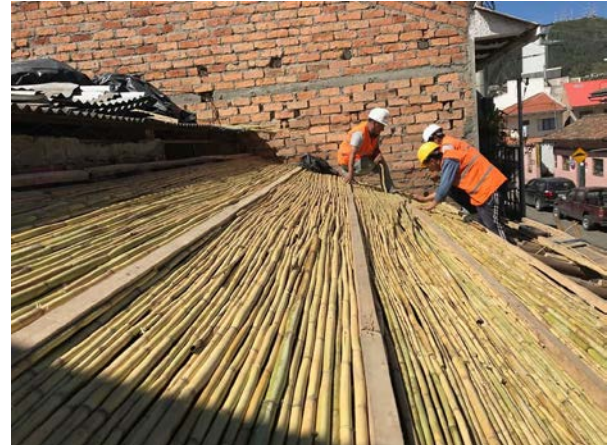
Figura 5. Incorporación de carrizo en cubierta sobre estructura de madera (Fuente: Proyecto Ciudad Patrimonio Mundial)
