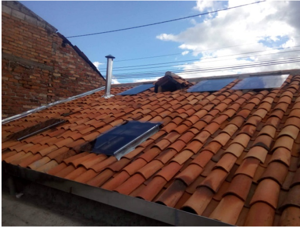
Figura 4. Intervención en cubierta, Campaña 2018 (crédito: T. Rodas)
