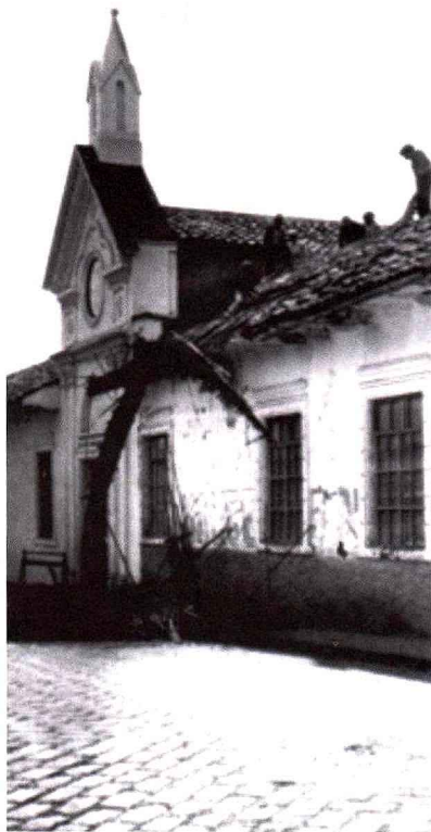
Frontis de la Casa de las Posadas durante su restauración, Cuenca, C. 1980. (Municipalidad de Cuenca. Archivo Fotográfico [MC]).
