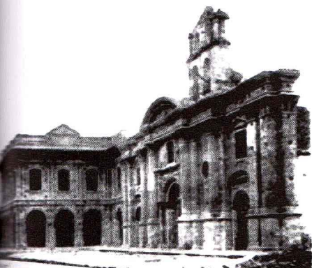
Templo de San Francisco, Cuenca, 1921, (OCHOA, Francisco, «El Templo y la Reconstrucción de San Francisco de Cuenca: Del Ocaso a la Renovación», Universidad de Cuenca, Facultad de Arquitectura, Tesis de grado, Cuenca, 2008 [FO]).
