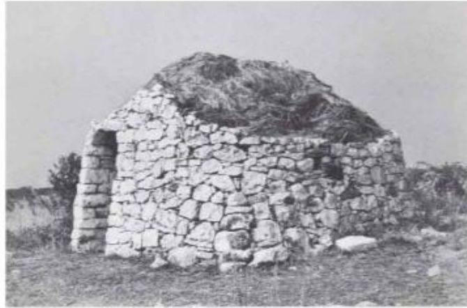
Fig. 2.1 Apilamiento de piedras naturales Fuente: (Zúñiga O. , 2005)
