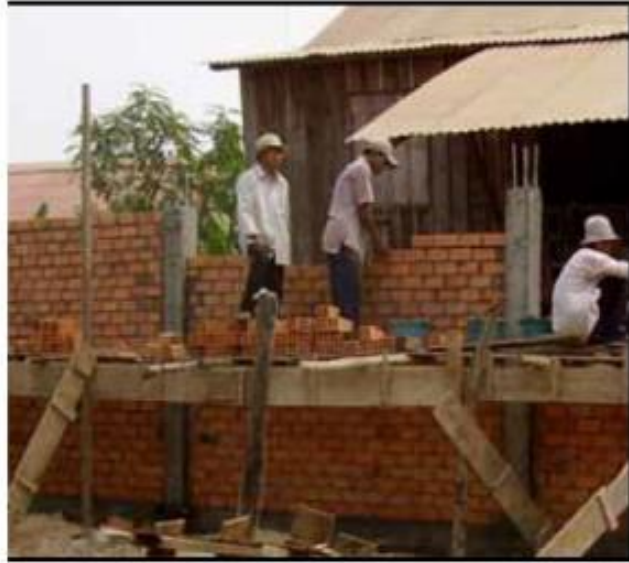
Fig. 2.6 Construcción de un pórtico relleno de mampostería Fuente: Brzev (2007)
