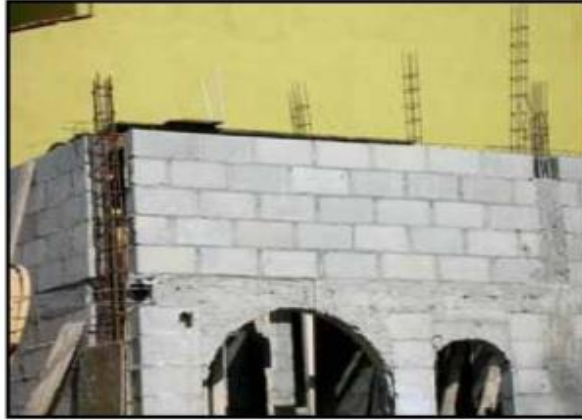
Fig. 2.5 Construcción de un muro de mampostería confinada Fuente: Brzev (2007)
