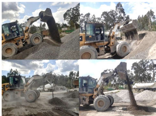
Figura 2. Formación de una pila menor de los áridos fino y grueso.
