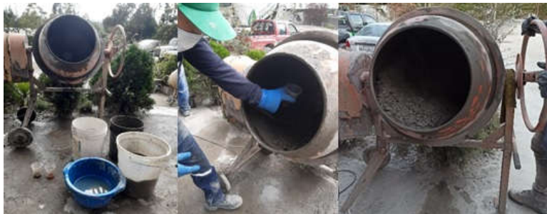
Figura 16. Preparación de la mezcla de hormigón.
