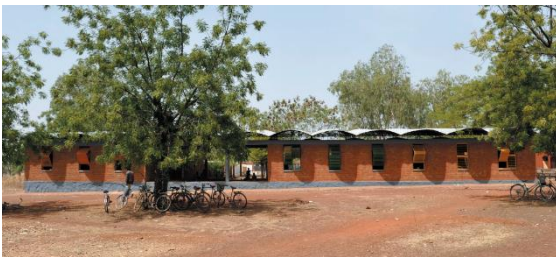
Figura 2.22: Extensión de Escuela Secundaria en Dano, Burkina Faso – Fachada sureste Fuente: Arquitectura Viva, 2018
