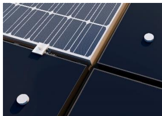
Figura 4.9: Integración de paneles PV y módulos dummy en la cubierta Elaboración: Propia
