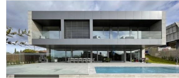
Figura 2.19: Passivhaus Boadilla del Monte Fuente: CSO Arquitectura, 2020
