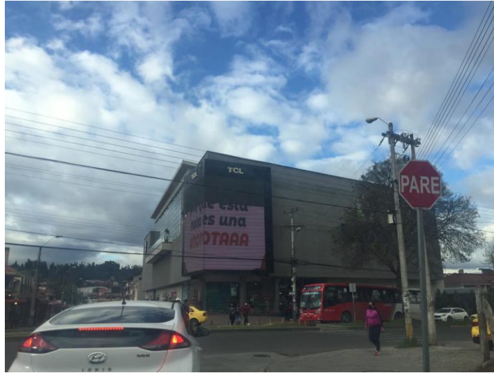
Figura 9. Centro Comercial Batán Shopping. Fotografía propia
