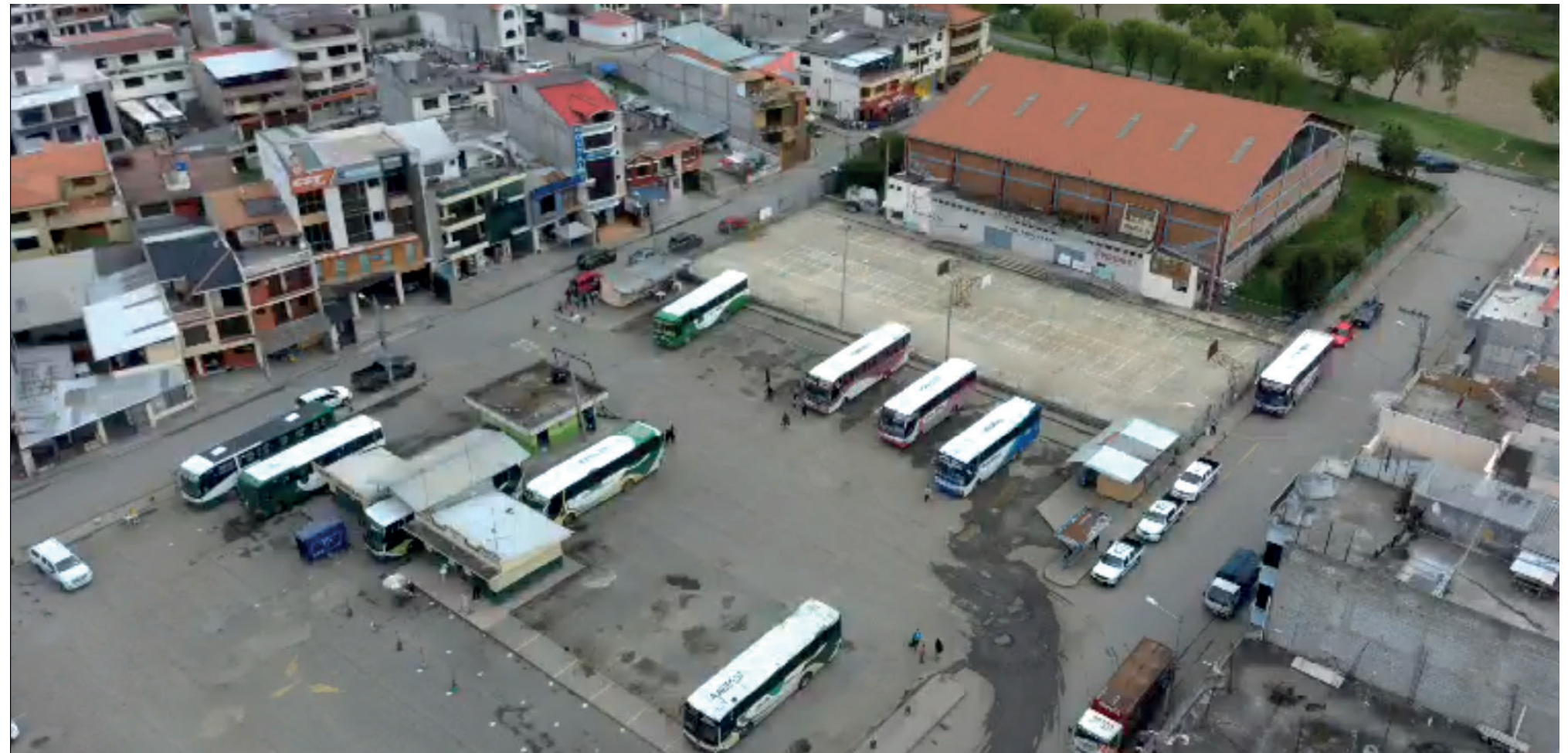
f7. Fotografía aérea, equipo de tesis.
