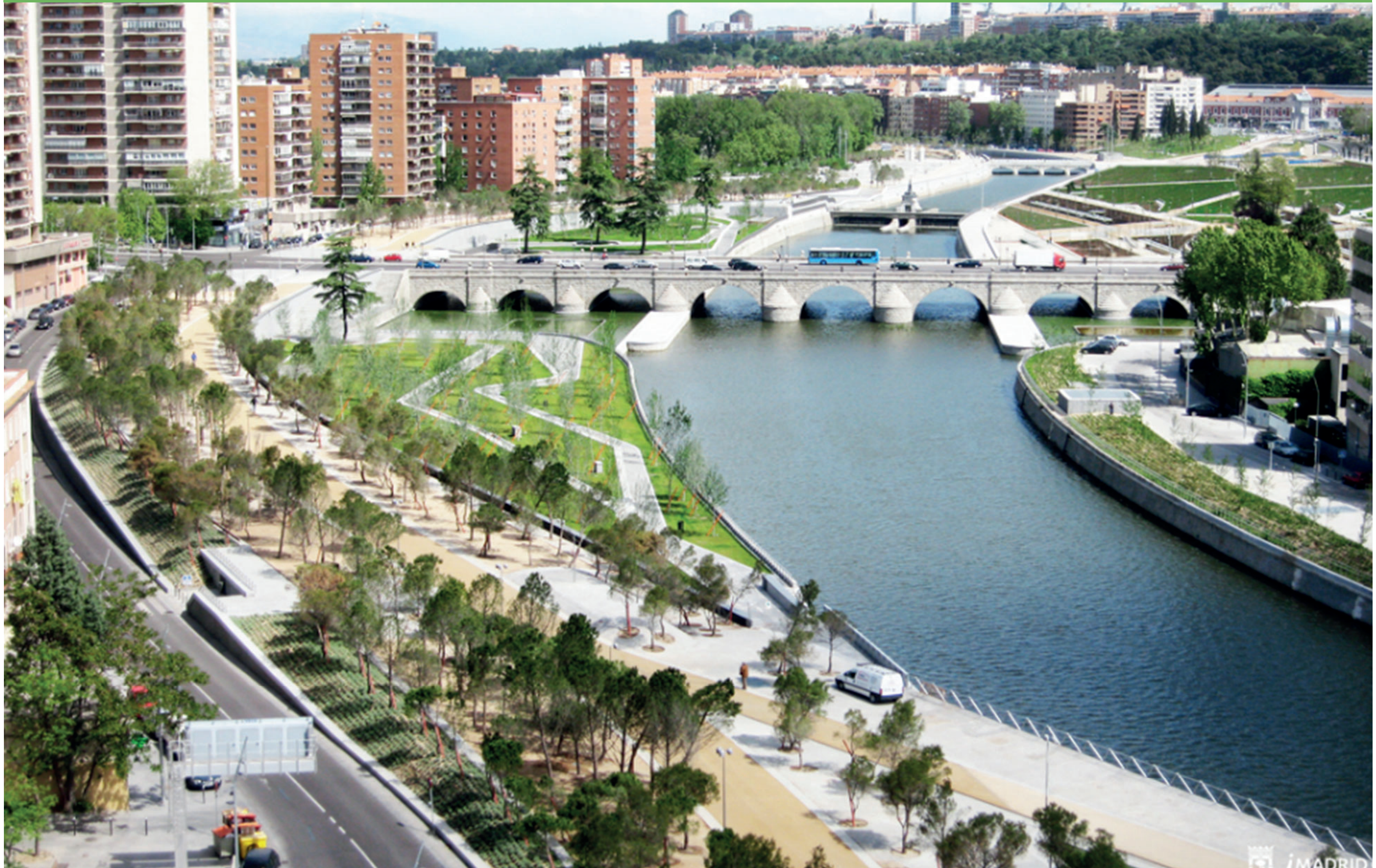
f37. Vista aérea tramo del proyecto madrid río, Madrid, Internet.
