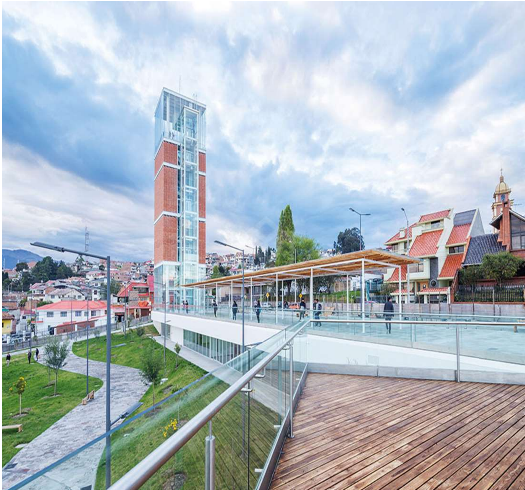
f17. Edificio mirador, terraza del parque La Libertad, Internet.
