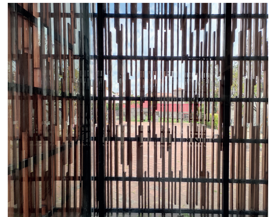
f36. Lamas bloques circulación, Fuente propia.
