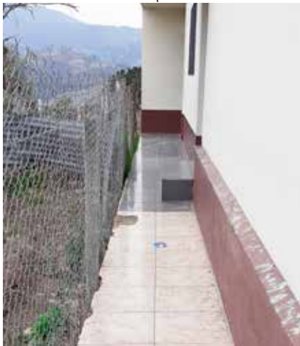
Figura 61. (V2.1) Pasillo lateral izquierdo.
