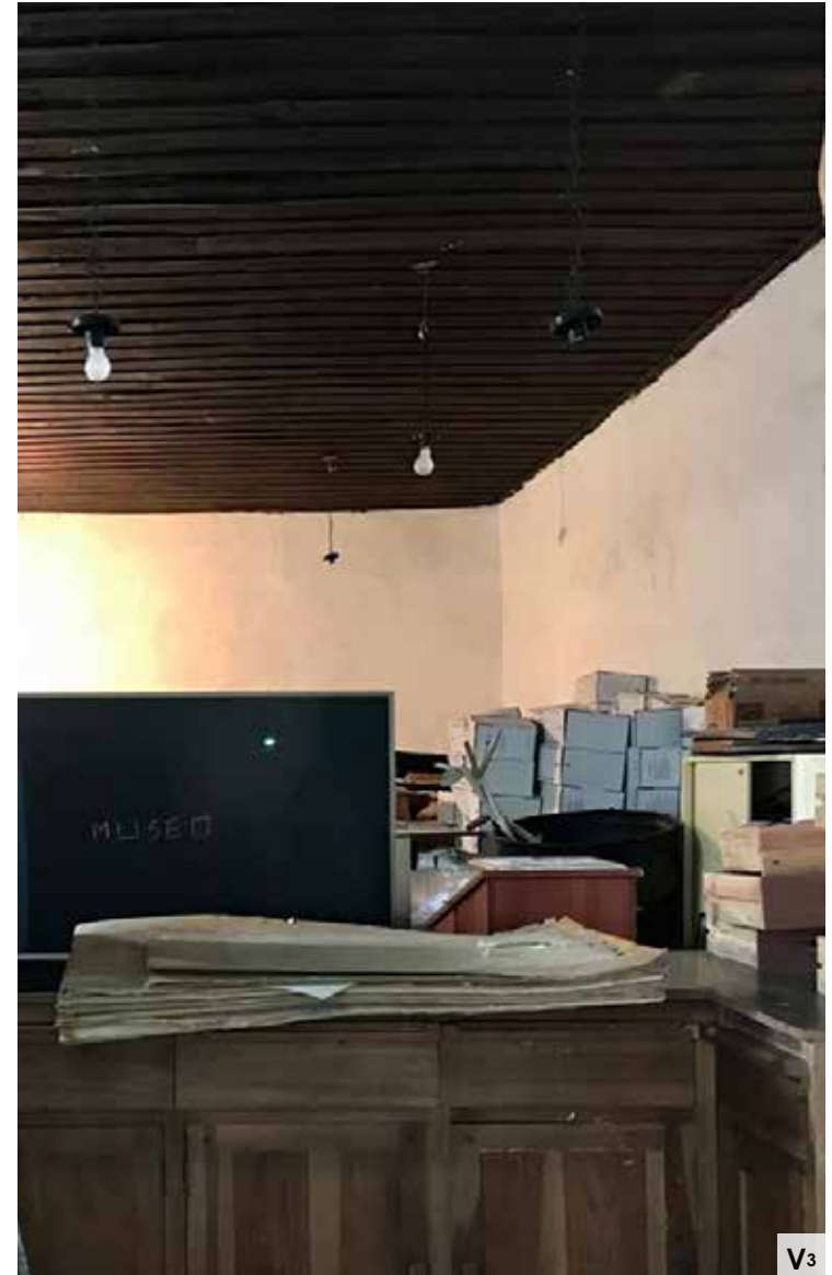
IMG 120. Vista 3 Bodega. Elaboración Propia
