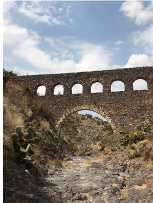
Imagen 33.- Acueducto de Camelia. Pachuca, México (2018)
