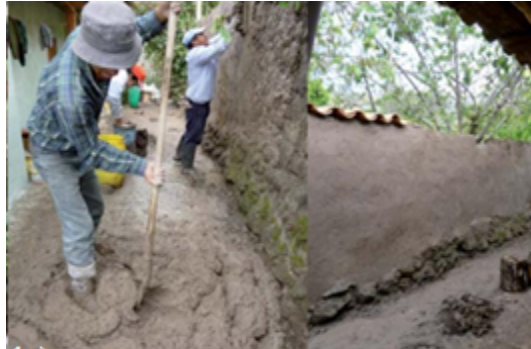
Figura 1 Foto: Revocado de tierra en la parroquia Susudel del Cantón Oña.
