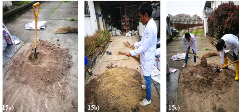
Figura 15 Fotos del proceso: tierra arcillosa 15a), adición de paja 15b), Mezcla 15c).
