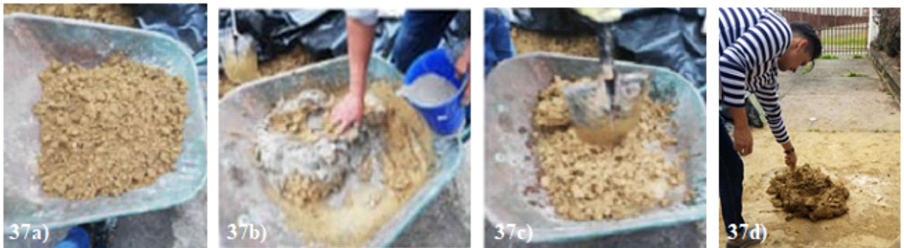
Figura 37 Fotos del proceso 1° capa: tierra arcillosa 37a), mezcla tierra arcillosa-arena 37b), adición de paja a la mezcla 37c), homogeneización 37d).
