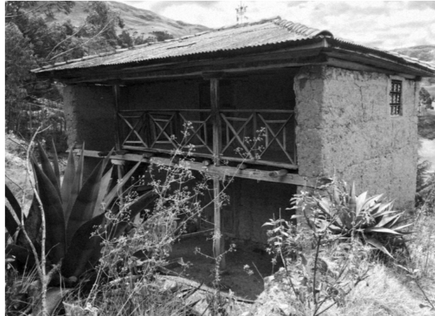
Figura 12. Solís, A. (2018). Vivienda de Arquitectura Vernácula en Cañar (Tapial) [Fotografía].
