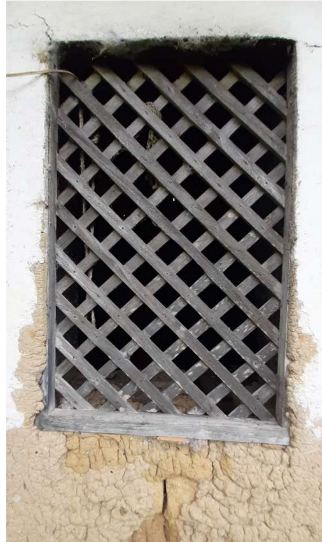
Figura 59. Equipo de tesis. (2020). Carpintería de madera [Fotografía].
