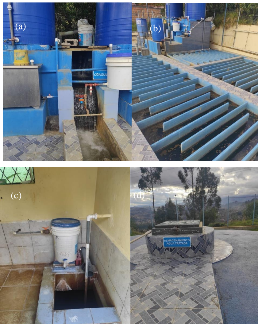
Figura 3. Proceso de potabilización de la planta de agua de JPAB: (a) entrada de agua a la planta (b) coagulación y floculación (c) sistema de cloración (d) tanque de almacenamiento.
