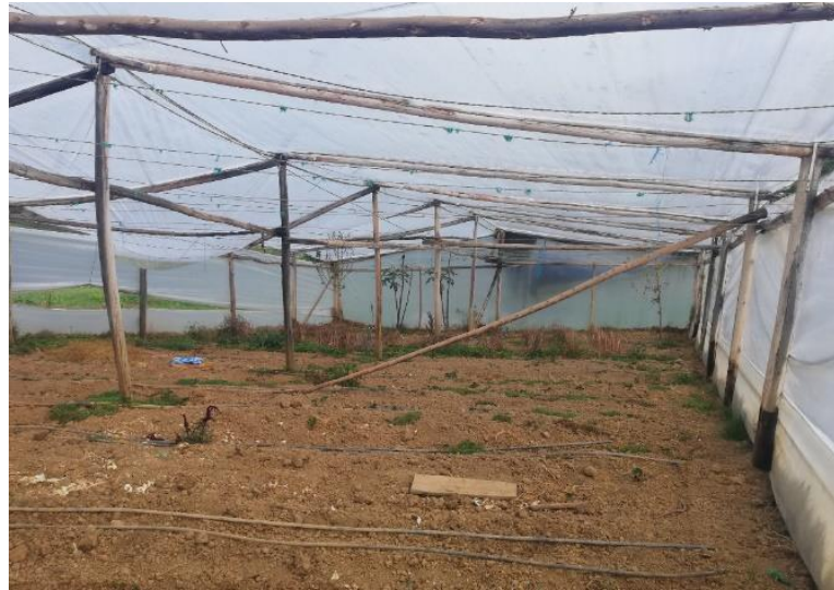
Figura 31. Estado inicial del invernadero
