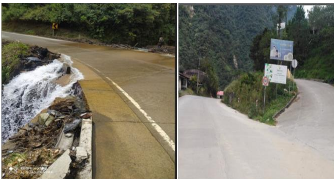
Foto 20 Condición de las vías
