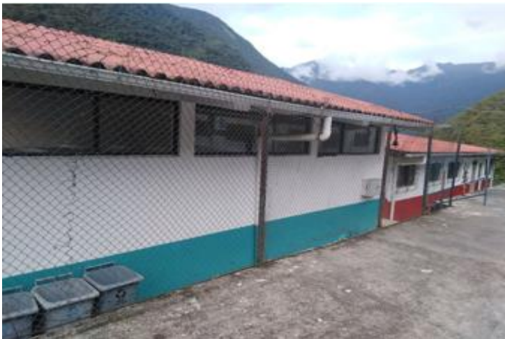
Foto 10 Antigua instalación del Colegio "Amaluza" en Amaluza
