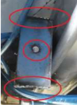
Figura 63: Soporte desprendido por fractura de perno y soldas Fuente: Javier Rodas López
