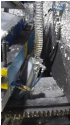
Figura 64: Pistón en mal estado producto del accidente Fuente: Javier Rodas López
