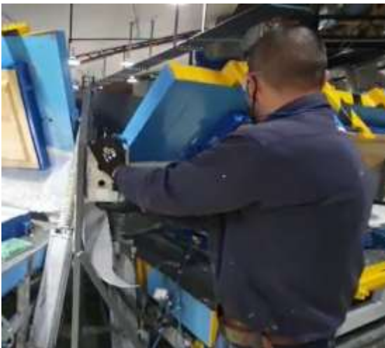
Figura 75: Inyección de poliuretano (paso 3) Fuente: Javier Rodas López
