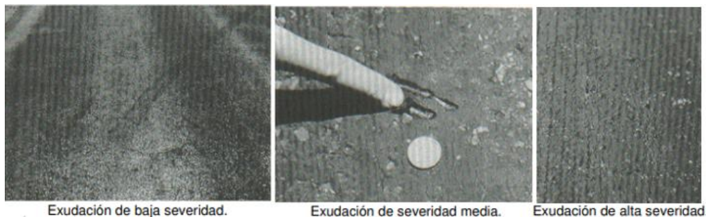
Figura 5. Imágenes para la identificación de fallas (Vásquez, 2002).
