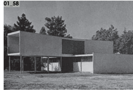
1951 Casa Heller o Casa Brown Beverly Hills, California Obra Construida demolida
