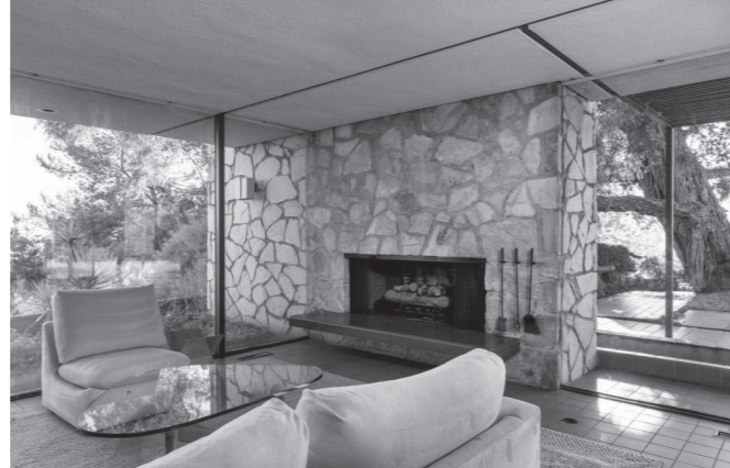
2.1_16 Extensión de paredes atravesando cerramientos perimetrales
