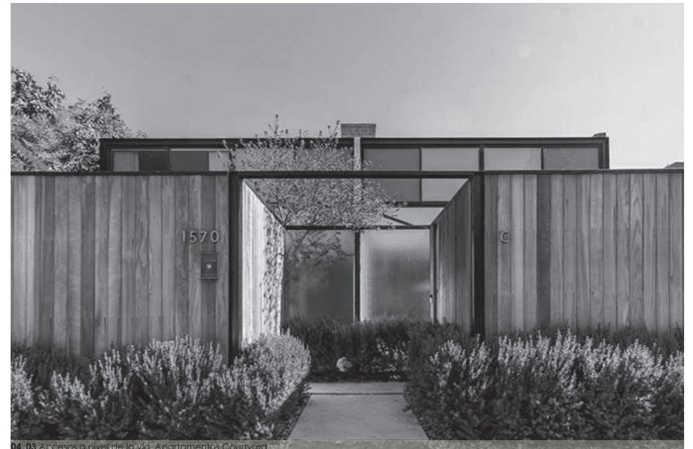
04_03 Accesos a nivel de la vía_Apartamentos Courtyard
