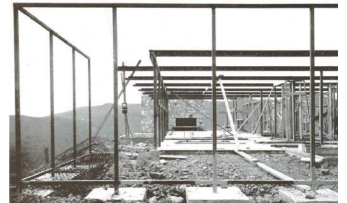
2.1_32 Montaje de la estructura principal
