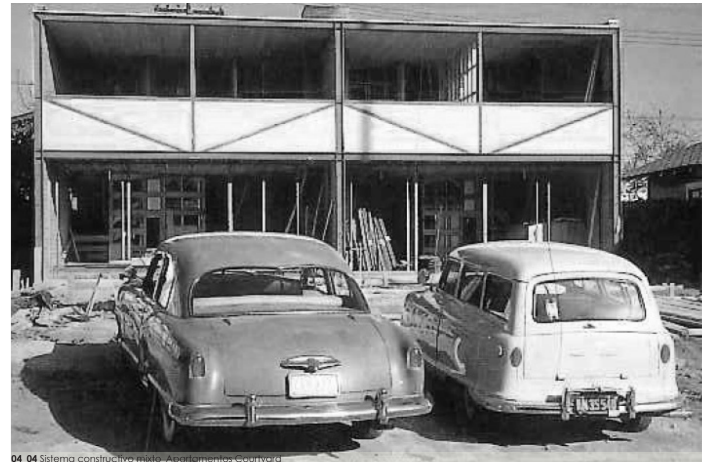
04_04 Sistema constructivo mixto - Apartamentos Courtyard
