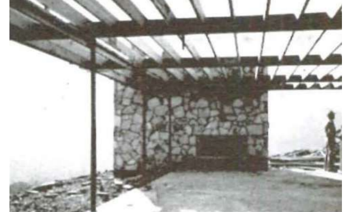
2.1_33 Montaje de la estructura secundaria
