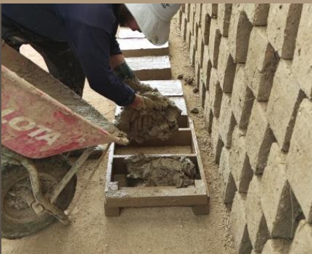
Ilustración 127. Moldeo del Adobe. PASO 1. Benalcázar, M., Zeas, V.,2020.
