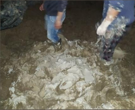
Ilustración 123. Colocación de cal en el barro. Benalcázar, M., Zeas, V.,2020.
