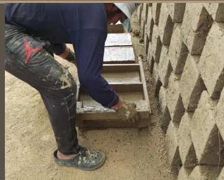
Ilustración 132. Moldeo del Adobe. PASO 6. Benalcázar, M., Zeas, V.,2020.
