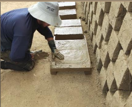
Ilustración 131. Moldeo del Adobe. PASO 5. Benalcázar, M., Zeas, V.,2020.
