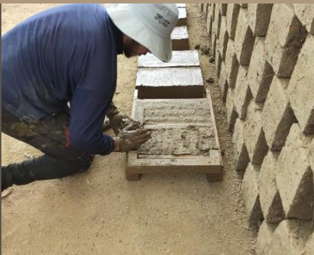
Ilustración 129.. Moldeo del Adobe. PASO 3. Benalcázar, M., Zeas, V.,2020.
