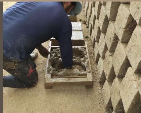
Ilustración 128. Moldeo del Adobe. PASO 2. Benalcázar, M., Zeas, V.,2020.
