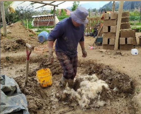
Ilustración 125. Colocación de cabuya en el barro. Benalcázar, M., Zeas, V.,2020.
