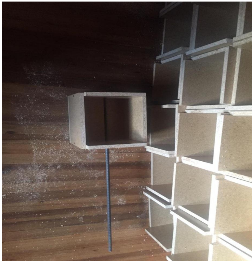
Figura 12: Encofrados
