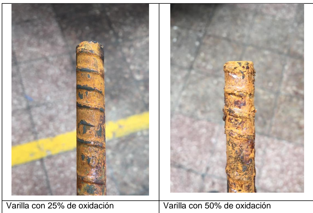
Figura 47: Varillas en estado de oxidación
