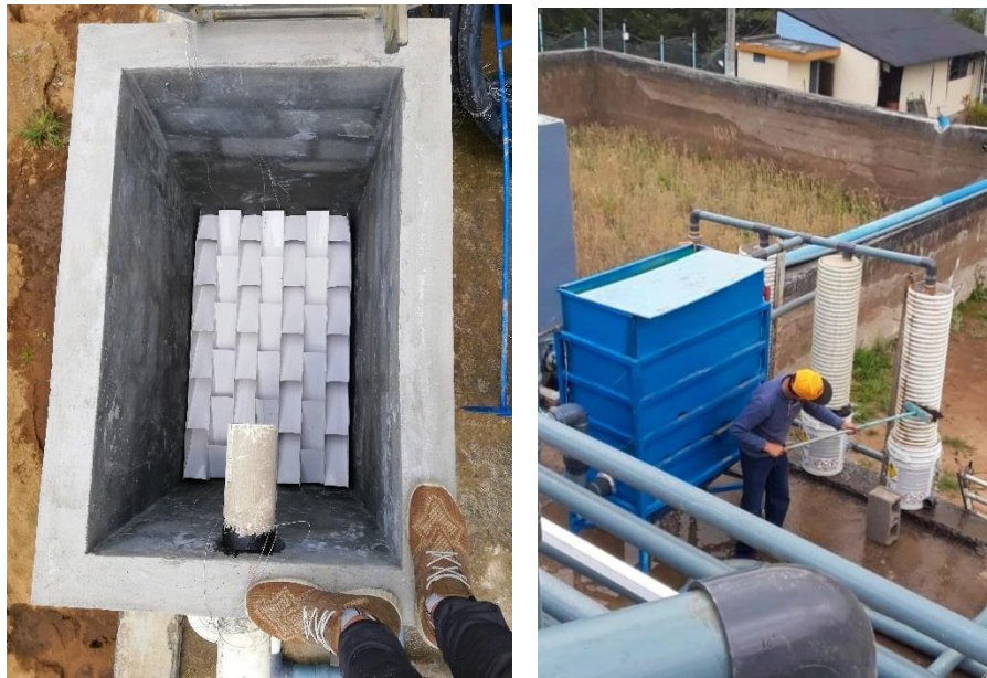
Figura 35. Construcción del Sedimentador y Filtro piloto.
