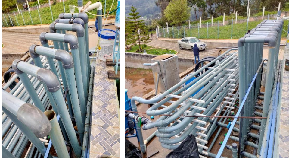
Figura 34. Construcción del FTV piloto.
