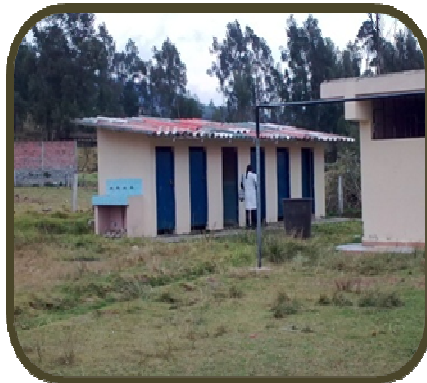
Exterior baterías sanitarias
