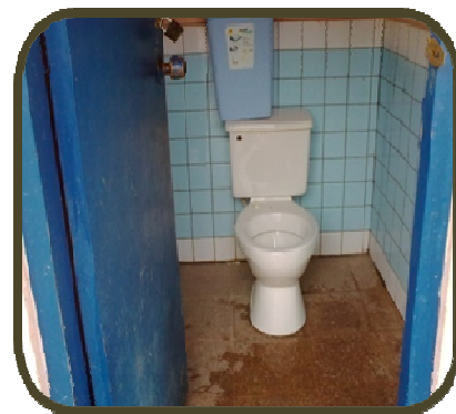
Interior baterías sanitarias
