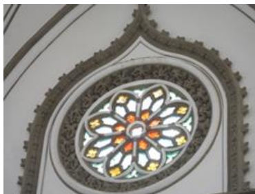
Ilustración 40. Fotografía del rosetón del transepto de la Iglesia Parroquial de Santiago de Calpi.
