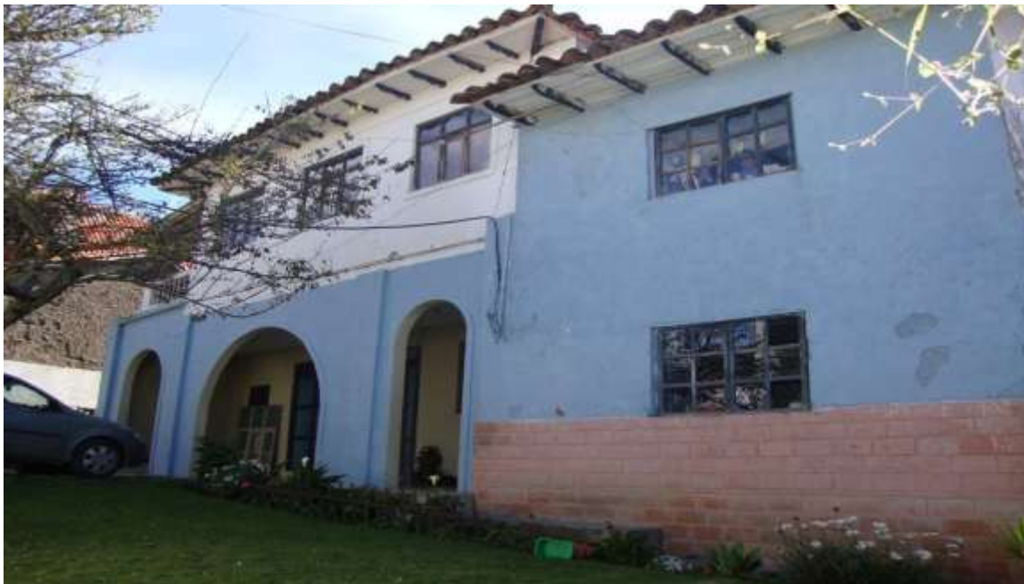
Foto 1. Primera infraestructura en donde funcionó la escuela Rafael Aguilar Pesantez Fuente: M. Herrera, D. Herrera, L. Jiménez
