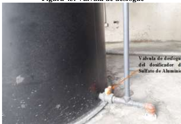
Figura 43. Válvula de desfogue
