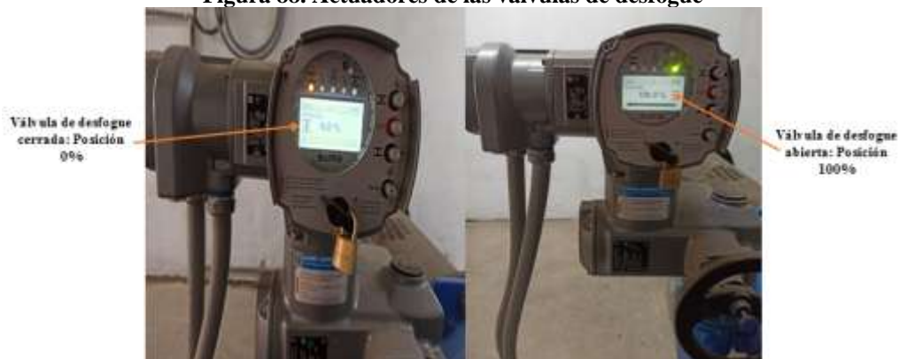
Figura 88. Actuadores de las válvulas de desfogue
