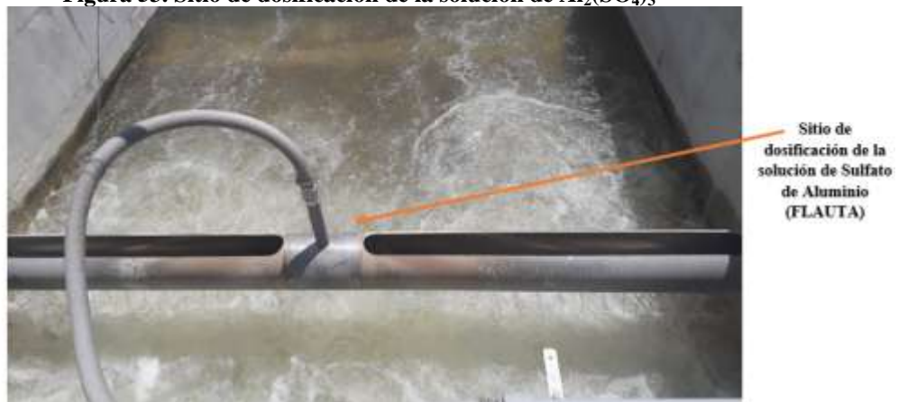
Figura 53. Sitio de dosificación de la solución de Al_2(SO_4)_3
