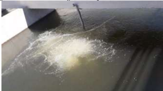
Figura 12. Aireador sumergible de flujo radial en funcionamiento
