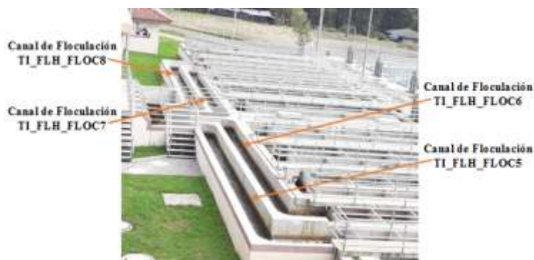
Figura 59. Canales de distribución hacia las unidades de floculación
