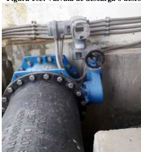
Figura 103. Válvula de descarga o desfogue
