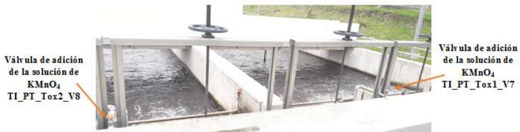
Figura 6. Válvula de adición de la solución de \text{KMnO}_4
