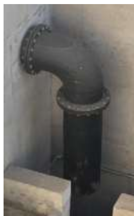
Figura 91. Tubería de ingreso de agua hacia los filtros
