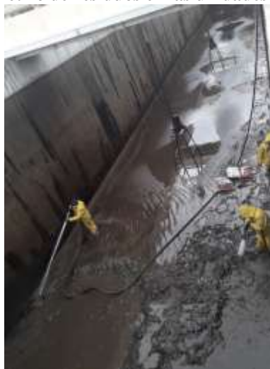
Figura 29. Retiro de residuos en las unidades de oxidación
