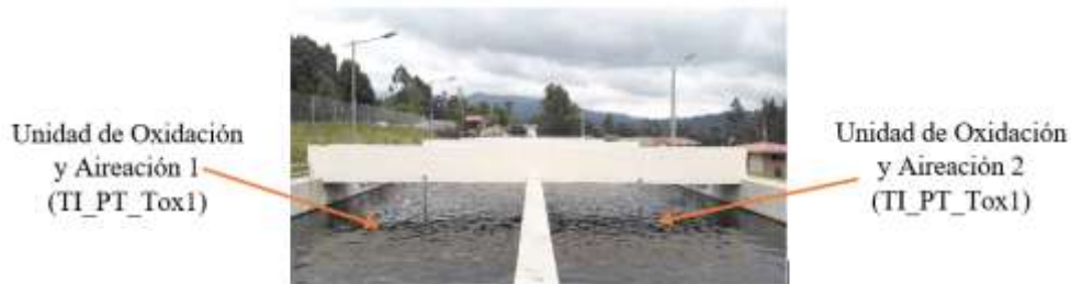
Figura 5. Unidades de Oxidación y Aireación
