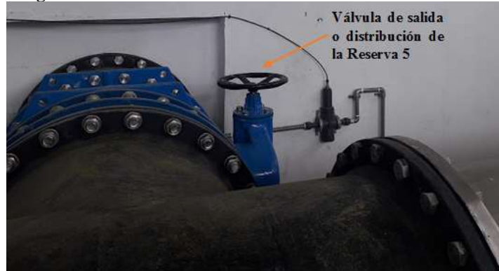
Figura 124. Válvula de salida o distribución de la Reserva 5
