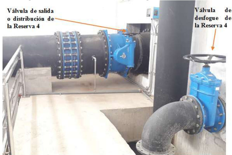
Figura 121. Válvula de salida y desfogue de la Reserva 4
