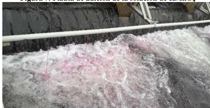
Figura 7. Flauta de adición de la solución de \text{KMnO}_4
