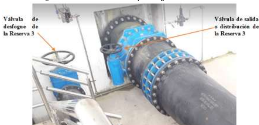
Figura 120. Válvula de salida y desfogue de la Reserva 3
