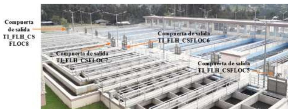
Figura 60. Compuertas de salida de cada unidad de floculación
