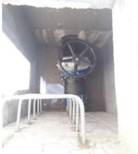
Figura 108. Válvula de vaciado de la cámara de filtración
