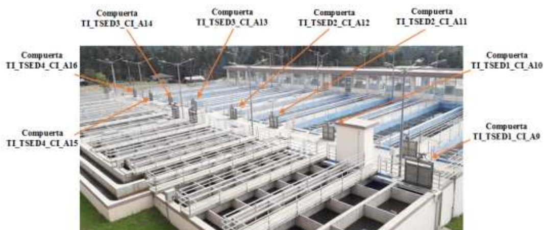
Figura 81. Compuertas de carga hacia las unidades de sedimentación
