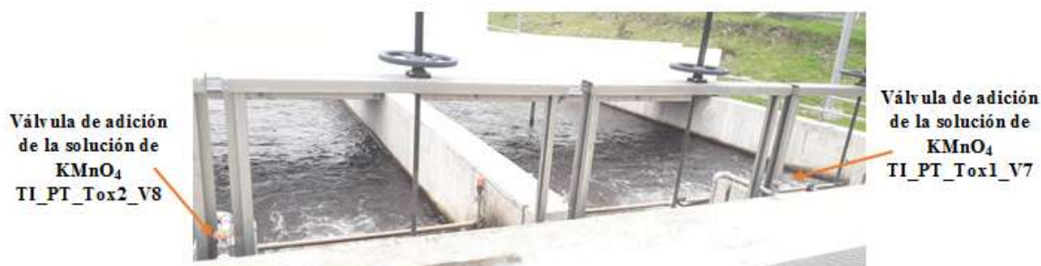
Figura 24. Válvulas de adición de la solución de KMnO_4
