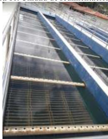
Figura 86. Unidad de sedimentación llena
