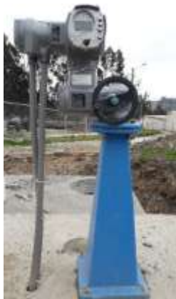
Figura 3. Actuador 2 – Conducción cerrada Saymirín – Tixán
