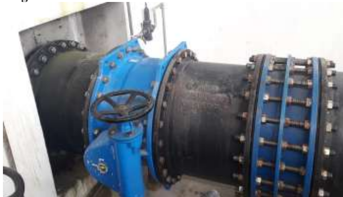
Figura 119. Válvula de salida o distribución de la Reserva 3
