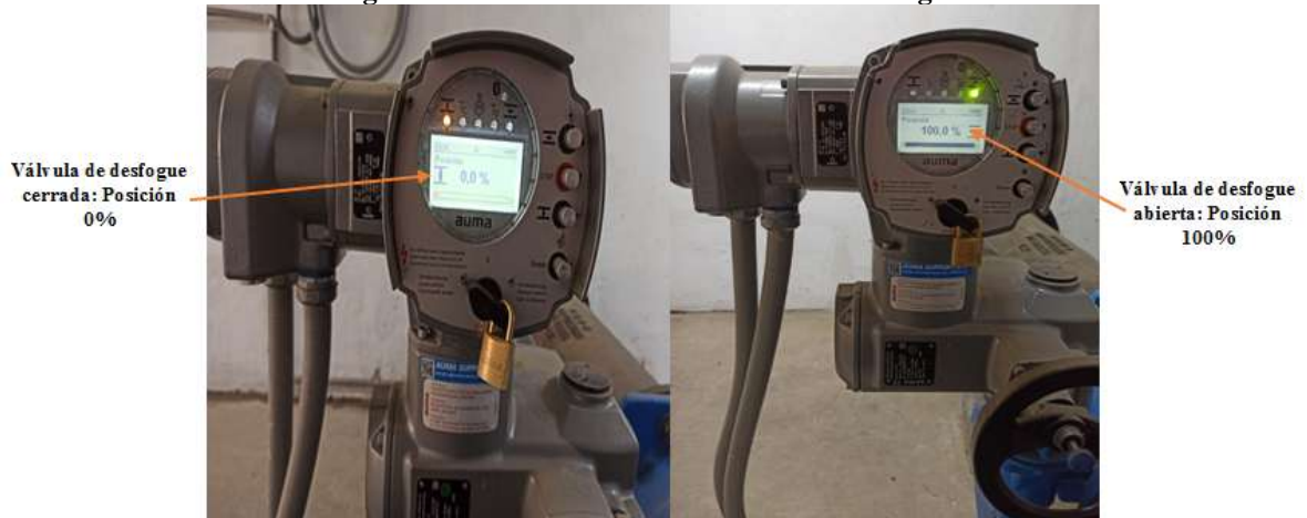
Figura 84. Actuadores de las válvulas de desfogue
