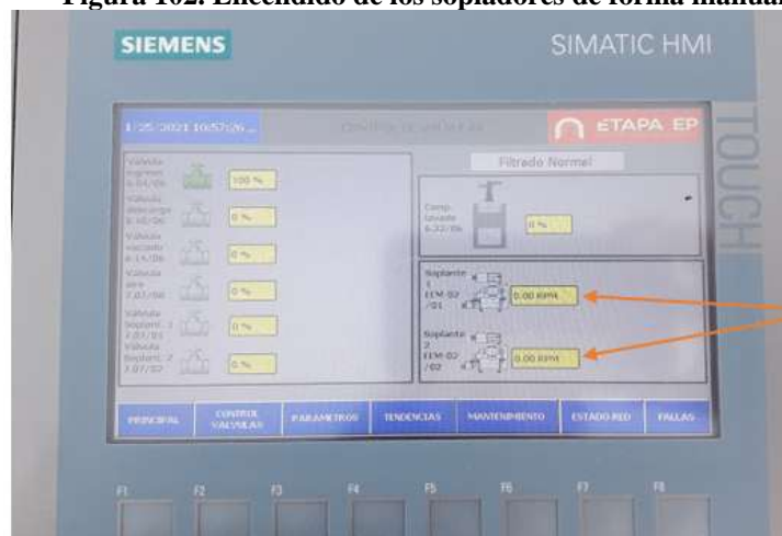
Figura 102. Encendido de los sopladores de forma manual
