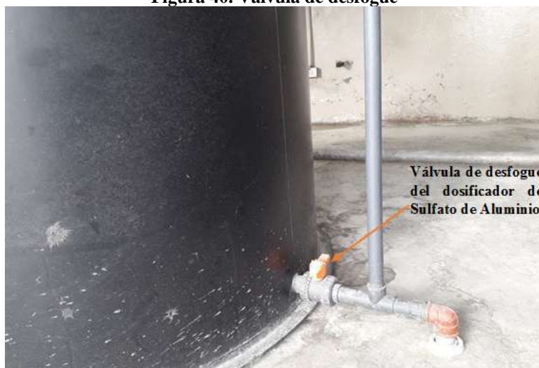
Figura 40. Válvula de desfogue
