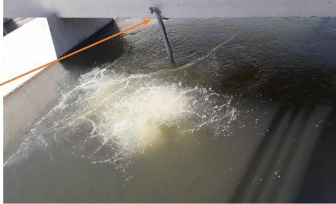
Figura 23. Aireador sumergible en funcionamiento
