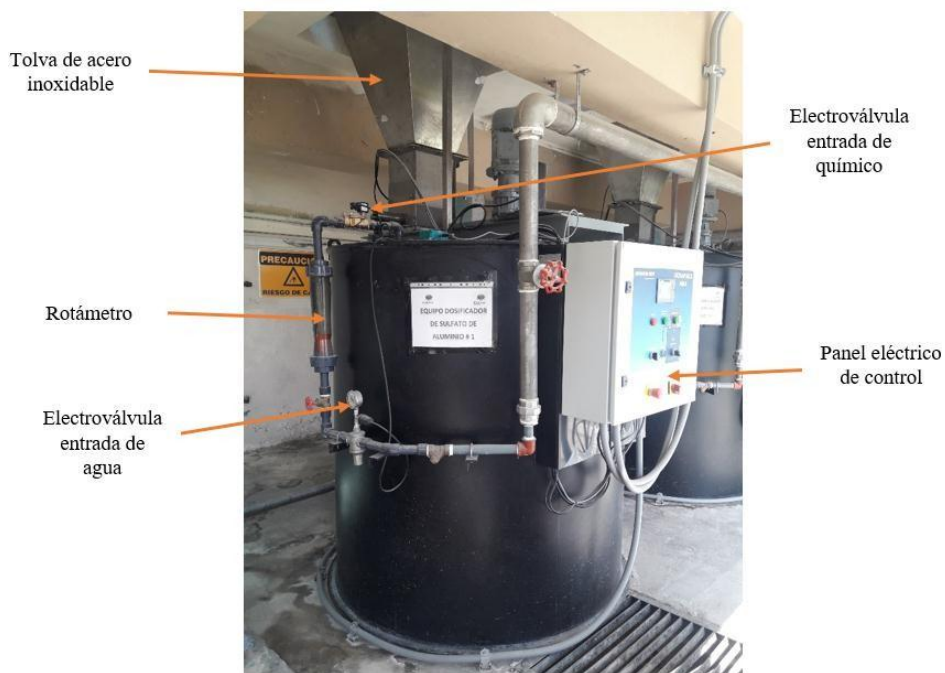
Figura 37. Sistema de preparación de reactivos - DOSAPACK MAX
