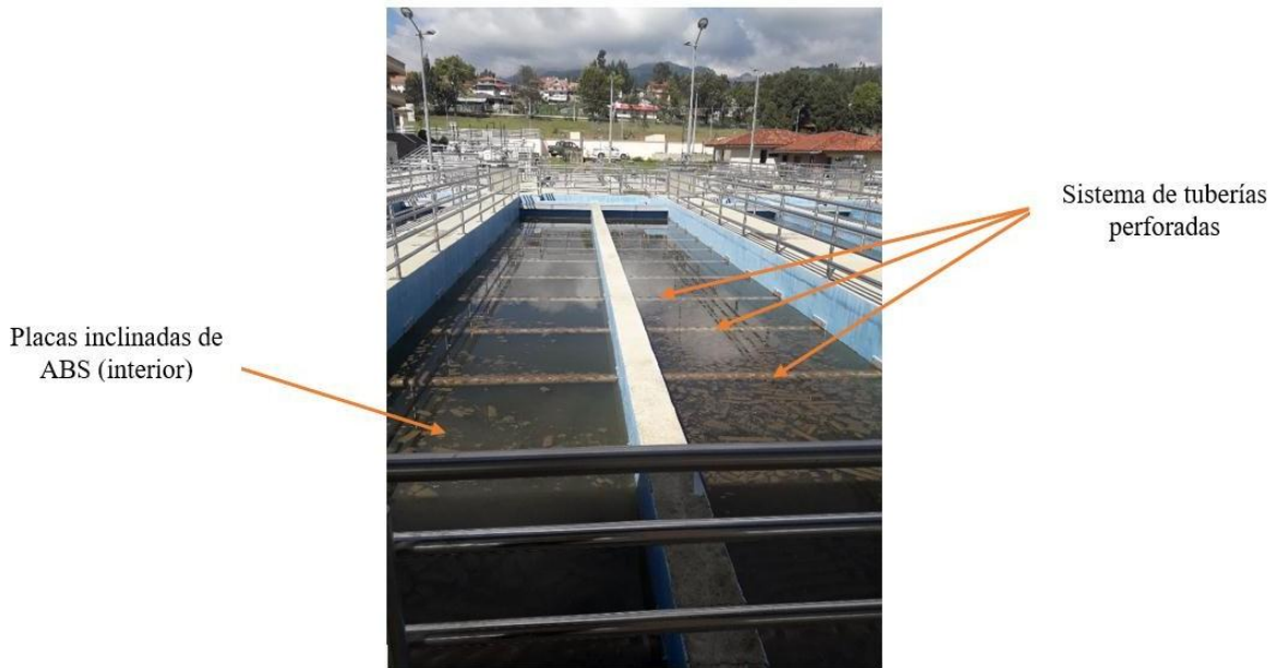
Figura 28. Unidad de sedimentación
