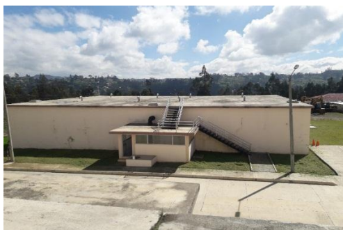
Figura 32. Tanque de almacenamiento #5
