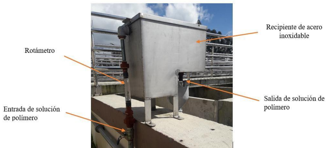
Figura 26. Sistema de distribución de solución de polímero
