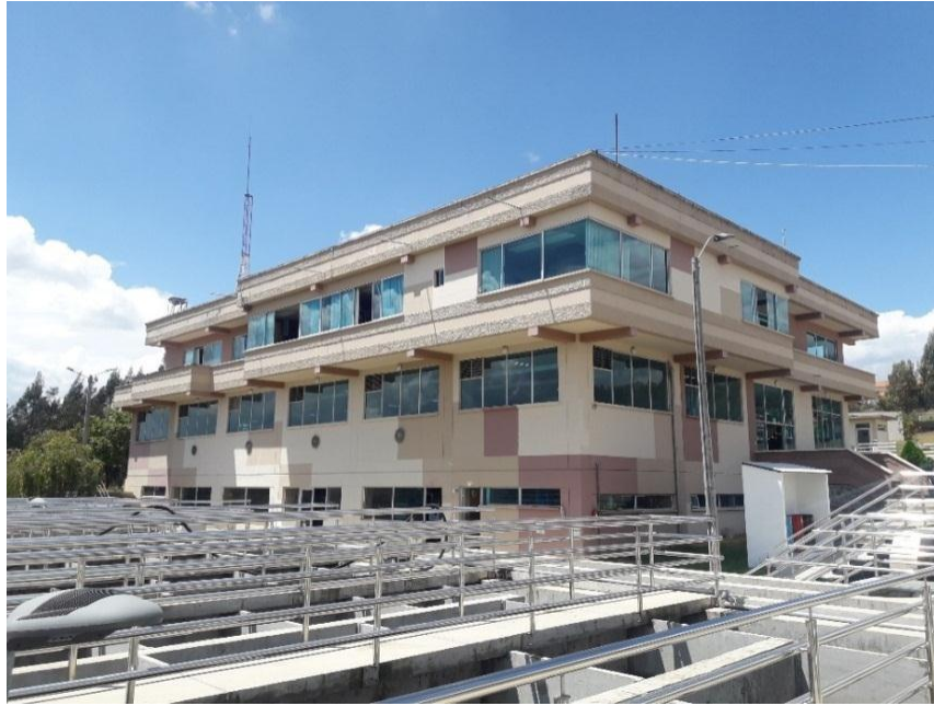
Figura 17. Edificio Principal de oficinas, bodegas de químicos y equipos dosificadores
