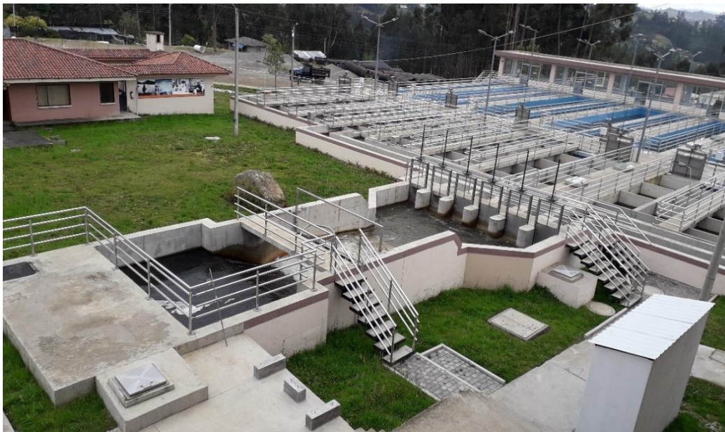
Figura 16. Planta de tratamiento de agua potable - Modulo II
