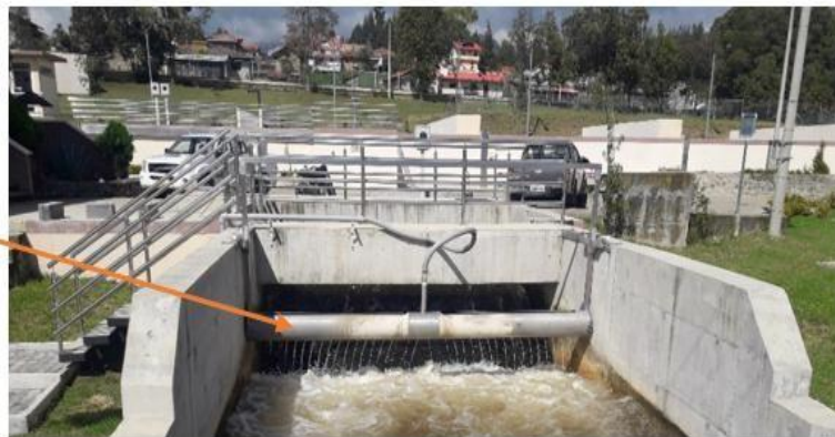
Figura 24. Unidad de mezcla rápida
