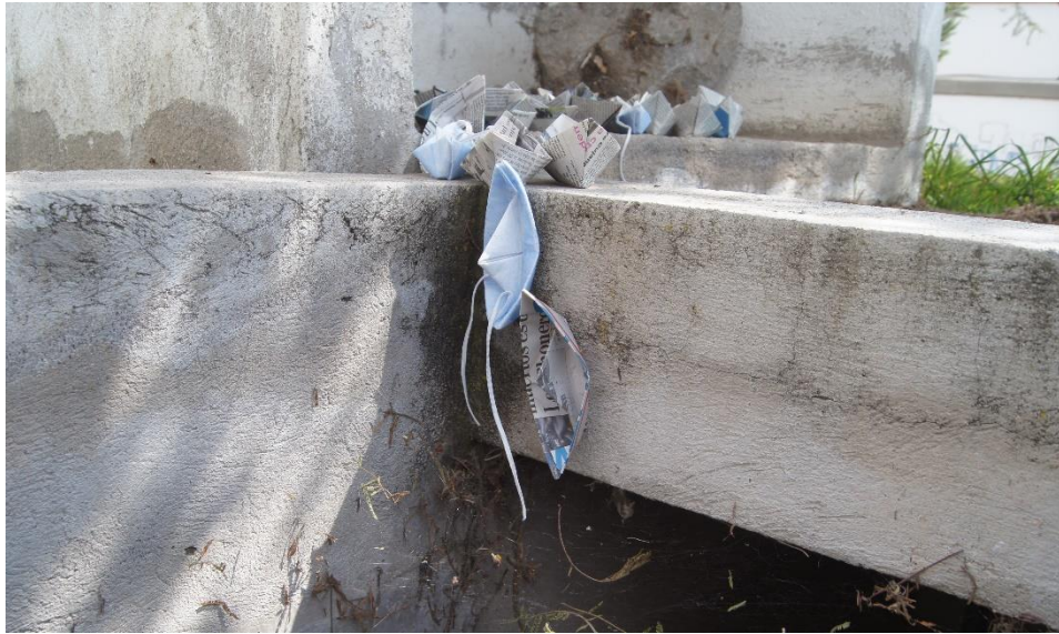
Imagen 60: Detalle de la obra. Registro del autor
