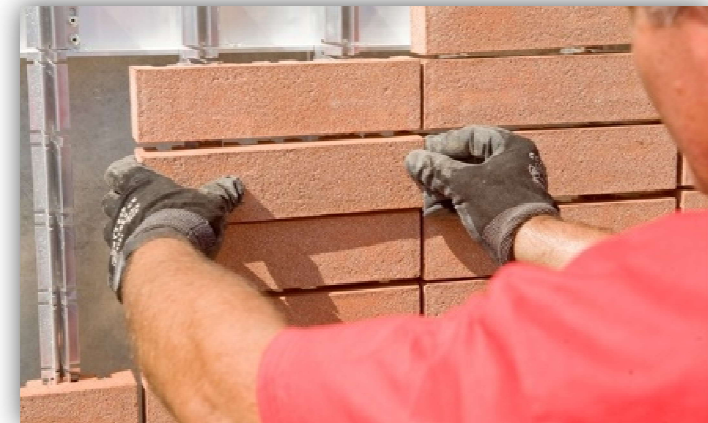
Imagen 1.30 Instalación de fachaleta con cuatro guías posteriores tomado de: http://www.terremilia.com/Sezione.jsp?idSezione=164
