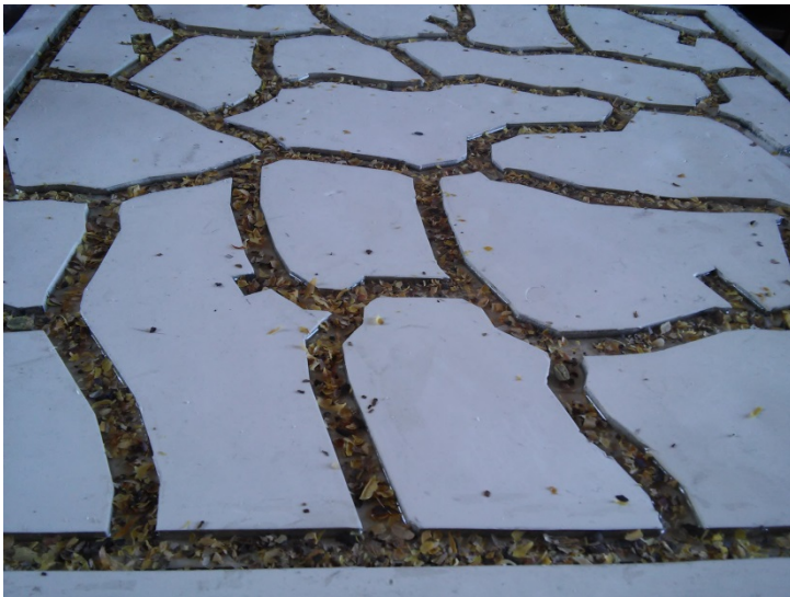
Imagen 4.32 Sellado con segunda y tercera capa de resina
