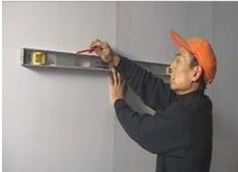
Imagen 1.36 Preparación de pared tomado de: http://decomode.mx/instalacion/
