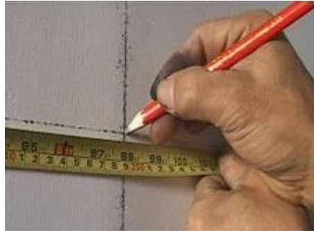
Imagen 1.37 Medida de pared tomado de: http://decomode.mx/instalacion/
