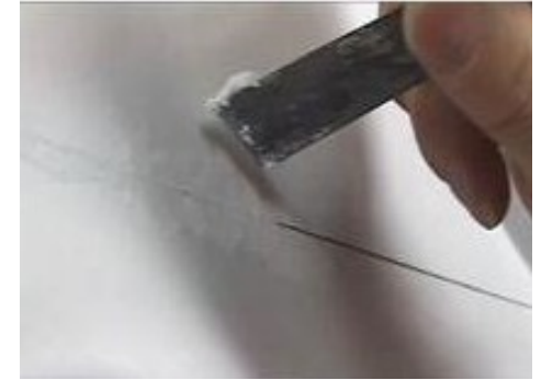
Imagen 1.41 Empaste en uniones tomado de: http://decomode.mx/instalacion/
