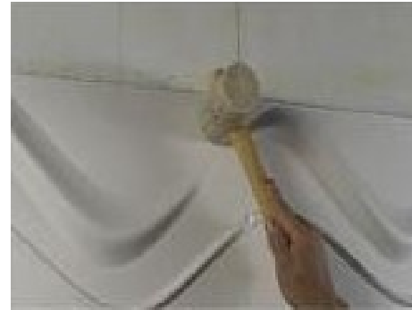
Imagen 1.40 Fijación y presión de panel tomado de: http://decomode.mx/instalacion/
