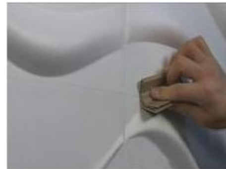
Imagen 1.42 Lijado en uniones tomado de: http://decomode.mx/instalacion/
