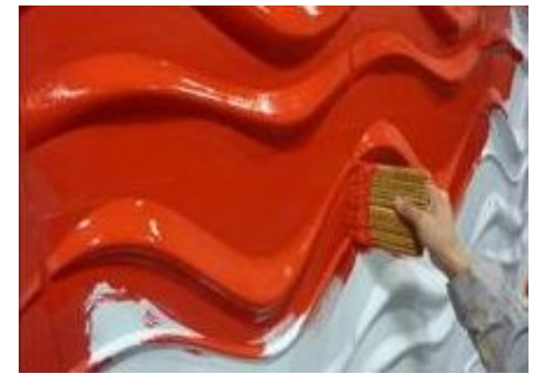
Imagen 1.43 Pintado de panel tomado de: http://decomode.mx/instalacion/
