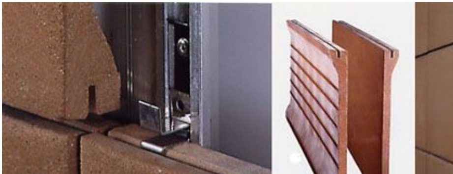
Imagen 1.34 Instalación de fachaleta con cuatro guías laterales tomado de: http://dimensioneceramica.com/areapublica/rivestimenti/23_63_1.asp
