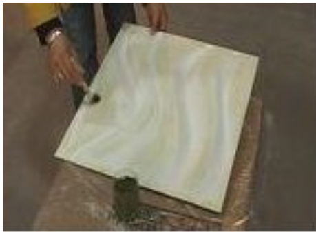
Imagen 1.38 Aplicación de pegante tomado de: http://decomode.mx/instalacion/
