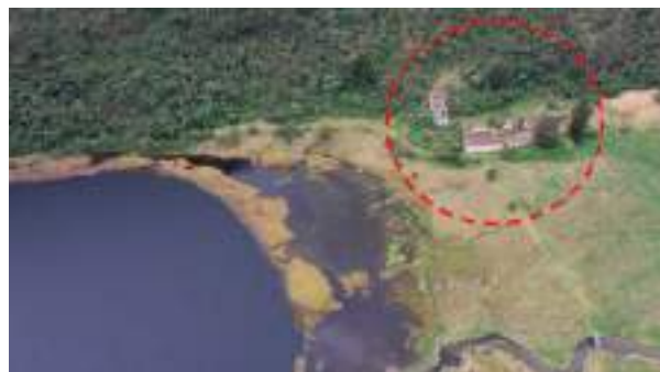
Figura 2: Laguna de Llaviucu - Antigua hacienda de Llaviucu, señalada en rojo, año 2016 (acervo del Proyecto vIirCPM)
