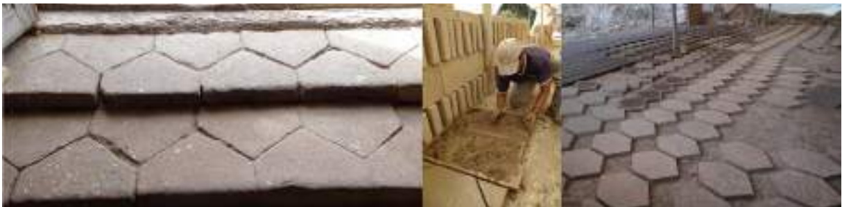
Figura 12. Ladrillos de la capilla de Susudel y nueva producción para el proyecto
