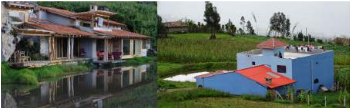
Figura 13. Dos edificaciones construidas en Susudel en el año 2016
