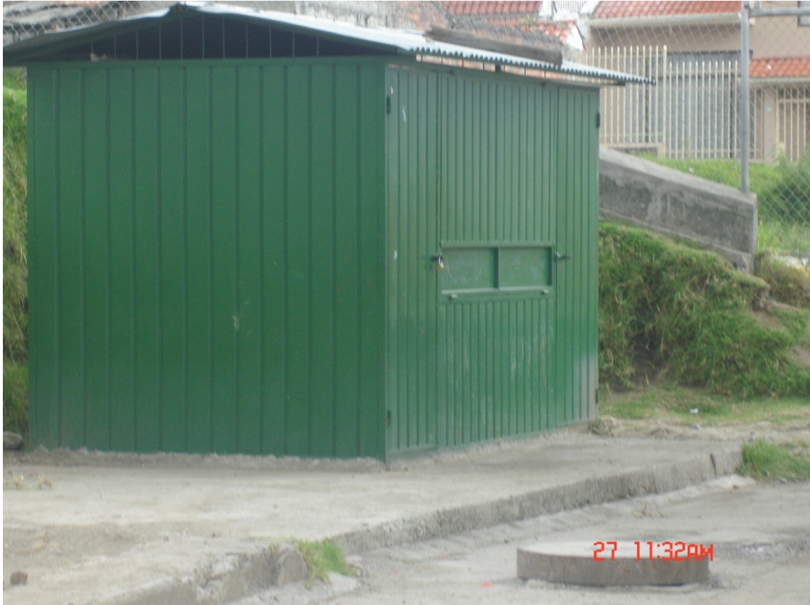
Foto 10: Estructura metálica del bar Escolar
