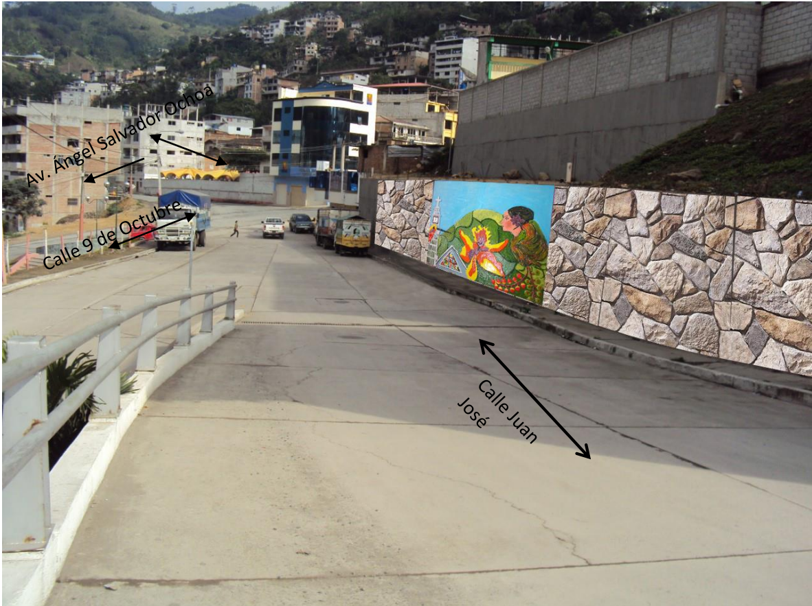
Primer Montaje, Vista de ángulo de Este a Oeste, Av. Ángel Salvador Ochoa, 9 de octubre y Juan José Loayza (2021)
