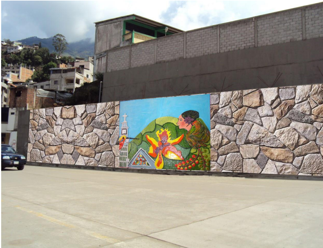
Primer Montaje, Vista de ángulo de Este a Oeste, Av. Ángel Salvador Ochoa, 9 de octubre y Juan José Loayza (2021)
