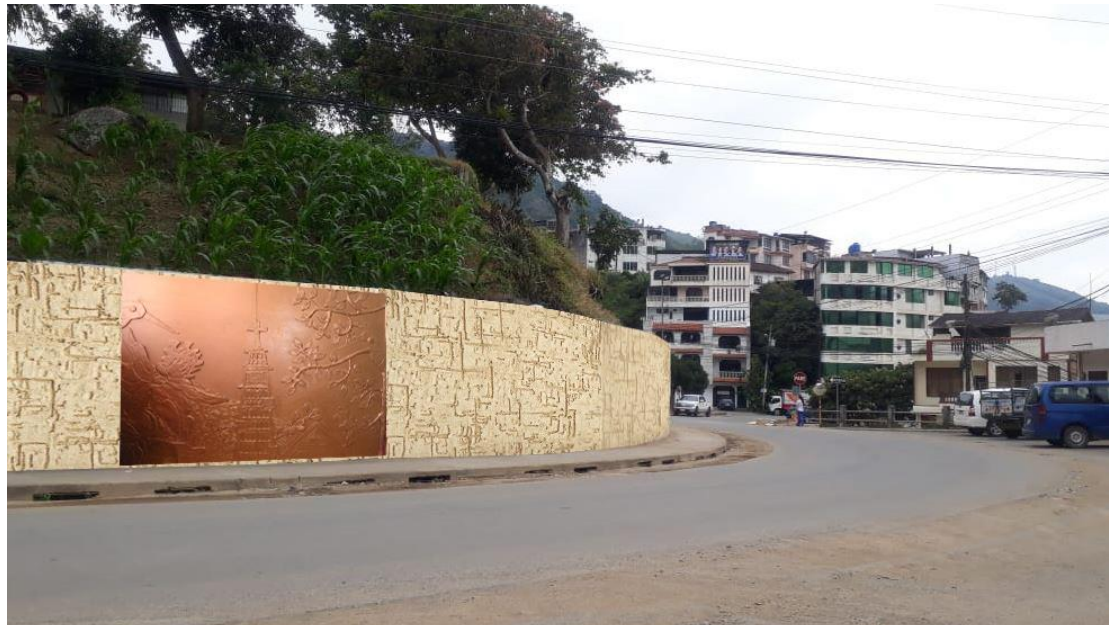
Segundo Montaje, Vista de ángulo al Este, Av. Ocho de Noviembre (2021)
