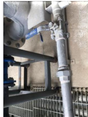
Ilustración 48 Válvula manual para la entrada de polielectrolito.
