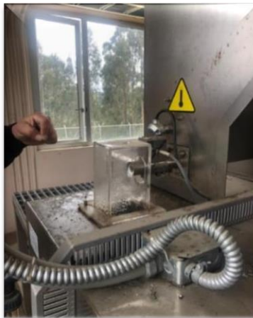
Ilustración 55 Tanque de preparación de polielectrolito.
