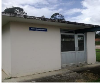
Ilustración 35. Estación de bombeo para cierre de Bypass.
