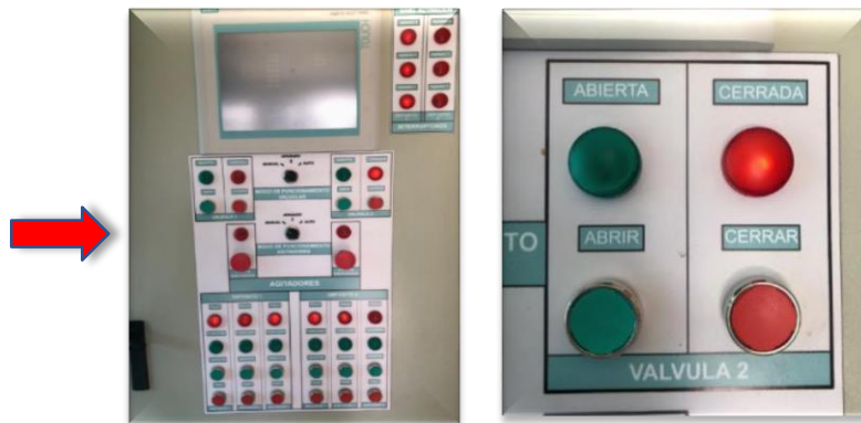
Ilustración 15. Tablero para control de válvulas V1 y V2.
