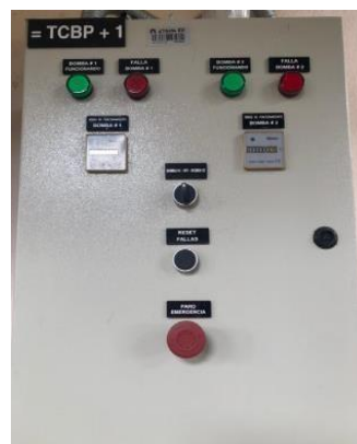
Ilustración 41. Bombas Polielectrolito.
