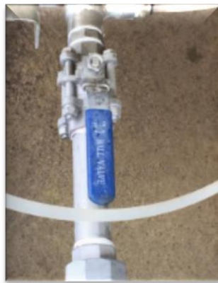
Ilustración 48 Válvula manual para la entrada de polielectrolito.
