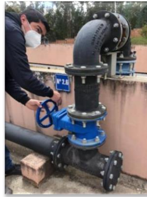
Ilustración 17. Abertura de válvula manualmente.
