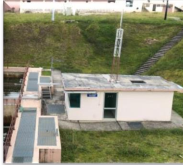
Ilustración 13. Sala de tableros y control.
