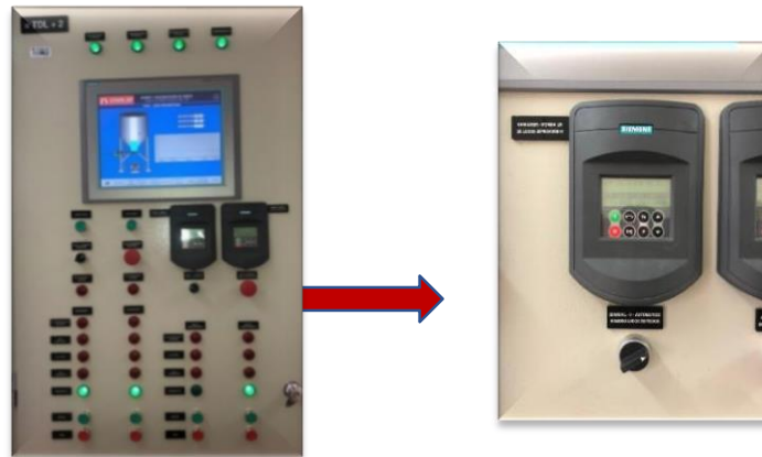
Ilustración 42 Botón para cambiar proceso de espesamiento a modo manual.
