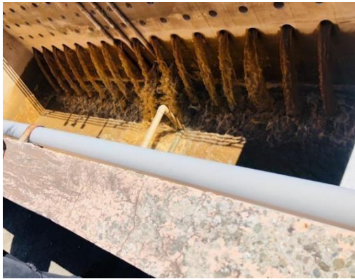
Ilustración 4: Llenado de tanque de decantación
