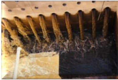
Ilustración 10 Tanques de decantación.
