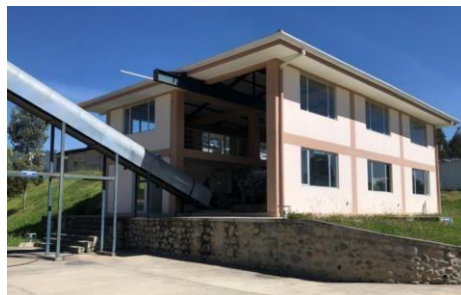
Ilustración 37. Edificio de deshidratación de lodos.
