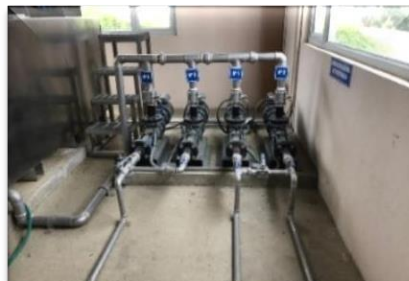
Ilustración 41. Bombas Polielectrolito.
