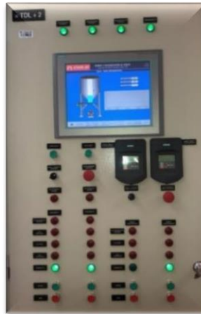
Ilustración 65 Tablero de selección de filtro a utilizar.
