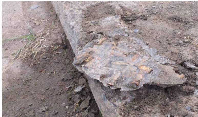
Ilustración 47, prueba 1: remoción de la intervención.
