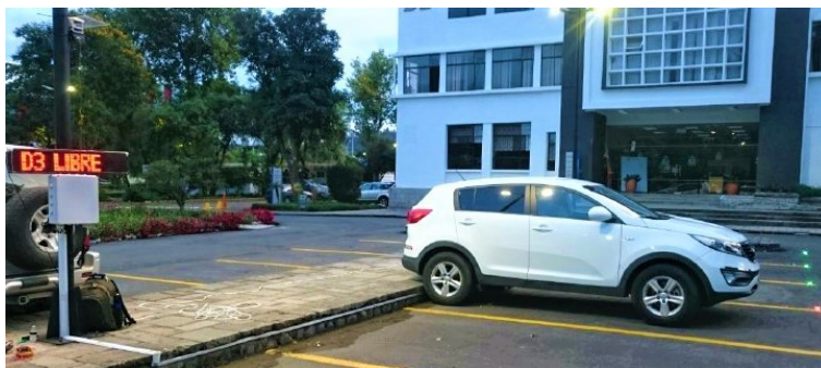
Figura 5.7: Subsistema de sensores instalado
