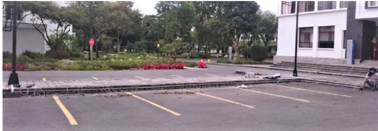
Figura 5.6: Instalación de subsistema de Sensores
