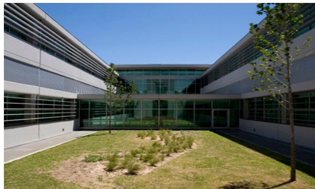
Imagen 2.35 | Patio interior (Mario Corea Arquitectura, 2010).
