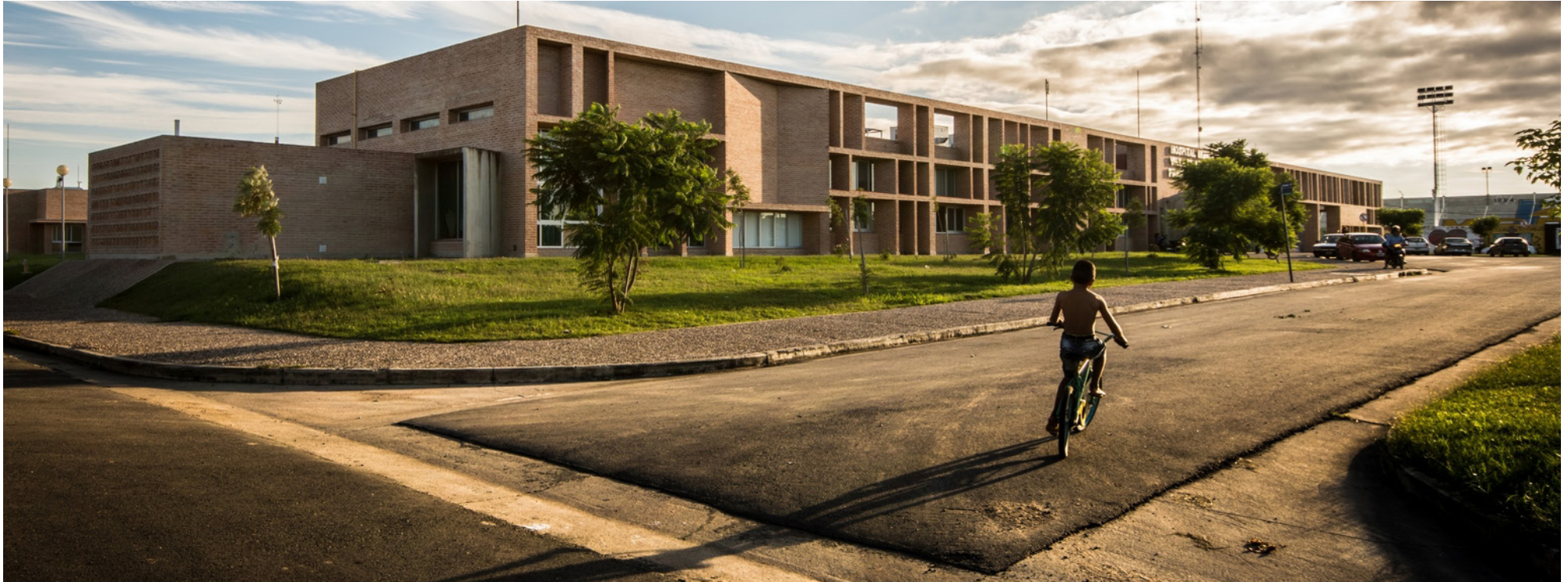
Imagen 2.11 | Vista Exterior (Gonzalo Viramonte,2007).
